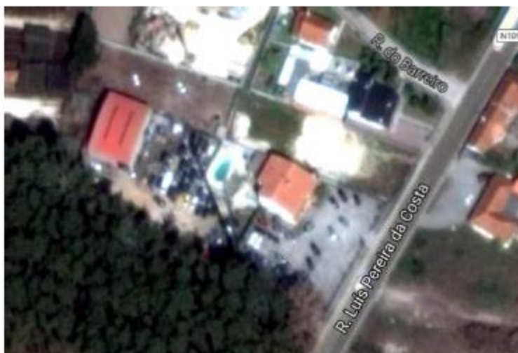
Edificado da operação de gestão de resíduos
