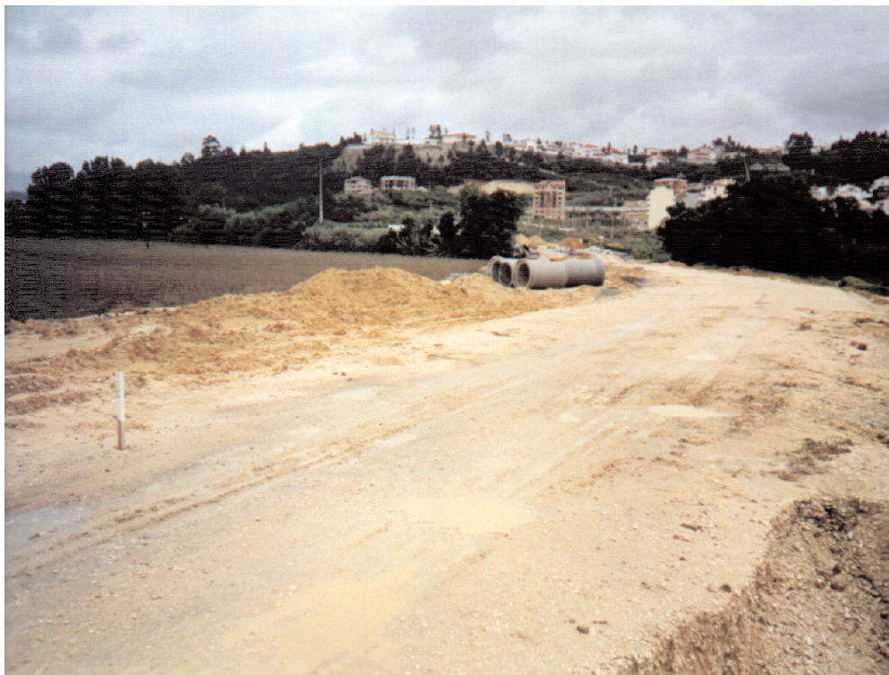
Aterro e plataforma da Variante Sul.
