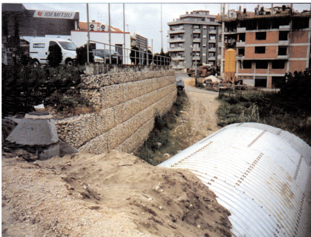
Passagem sob a Variante Sul, junto à rotunda "MacDonalds".
