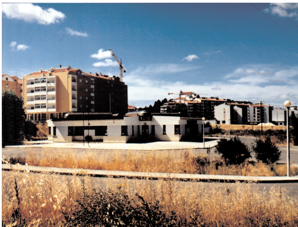
S. Romão. Instalações da D.G.Viação.
