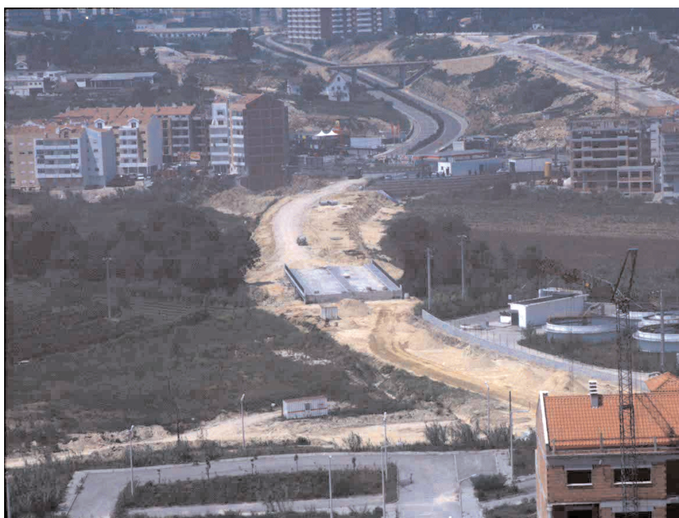
Variante Sul, ETAR, via de ligação à estrada de São Romão.
