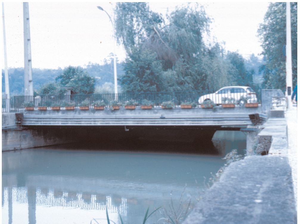
Ponte dos Caniços, de jusante para montante.
