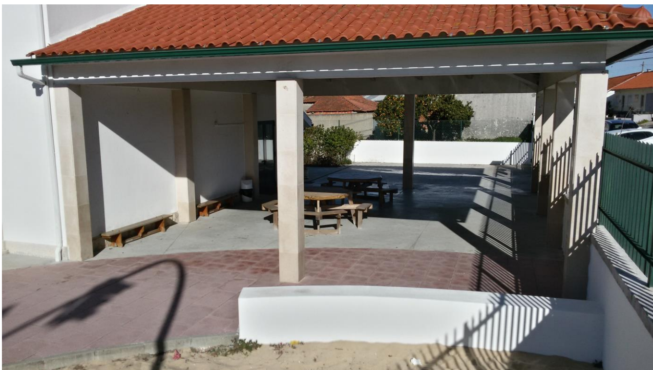
Fotografia.2 – Vãos do alpendre onde serão aplicadas as portas articuladas de harmónio.
