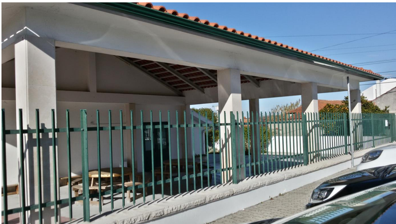
Fotografia.3 – Vãos do alpendre onde serão aplicadas as janelas fixas (Alçado Sul).
