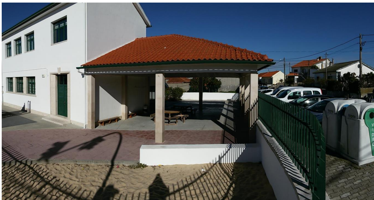
Fotografia.1 – Recreio coberto existente na Escola EB1 em A-dos-Pretos, Maceira.
