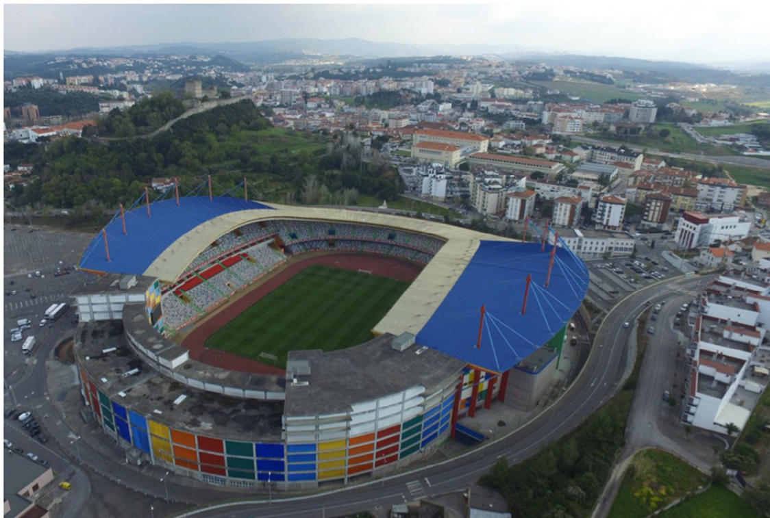
Fig. 1 – Edifício do Topo Norte
