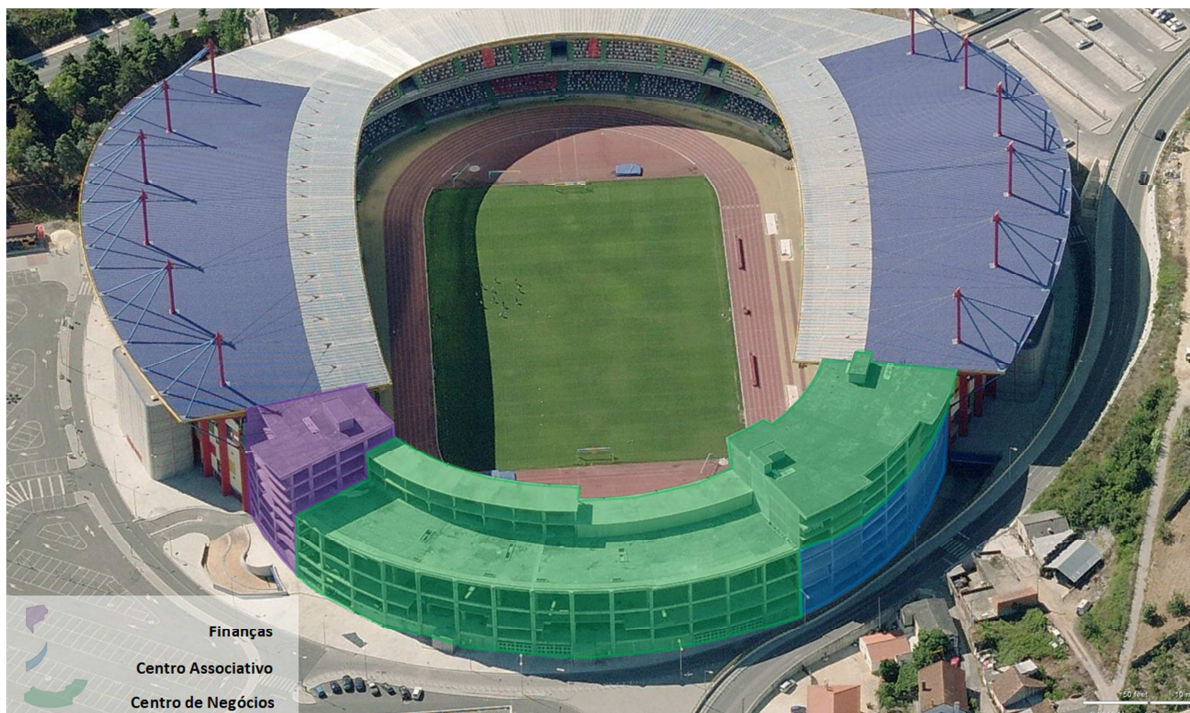
Fig. 9 – Reestruturação funcional do Topo Norte do Estádio Municipal.
