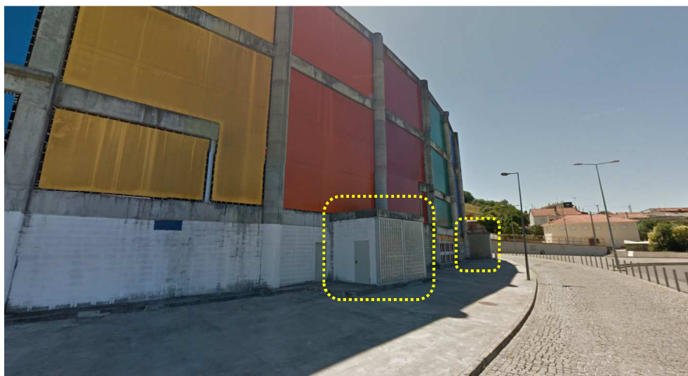
Fig. 14 – Identificação dos corpos avançados na fachada (através do traço interrompido amarelo).
