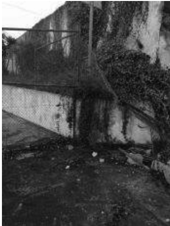
Fig.3 – Localização do muro de vedação (junto ao campo de jogos)
