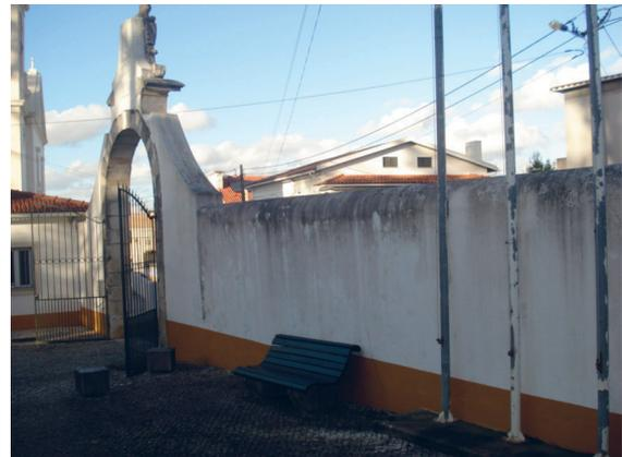
**Foto 16 – Degradação de fachadas do edifício devido á falta de isolamento (tinta)**
