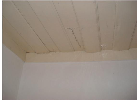
**Foto 7 – Tectos Interiores – Rotura parcial de forro em madeira por consequência de cedência da estrutura – Origem de infiltrações pela cobertura.**
