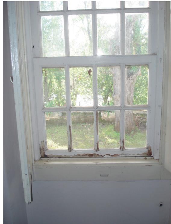
**Foto 12 – Degradação das caixilharias de madeira permitindo a penetração de água para o interior do edifício**
