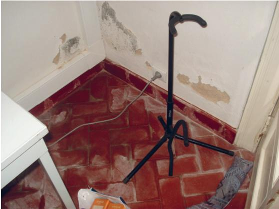
**Foto 9 – Paredes com salitre devido a humidade ascensional por capilaridade**
