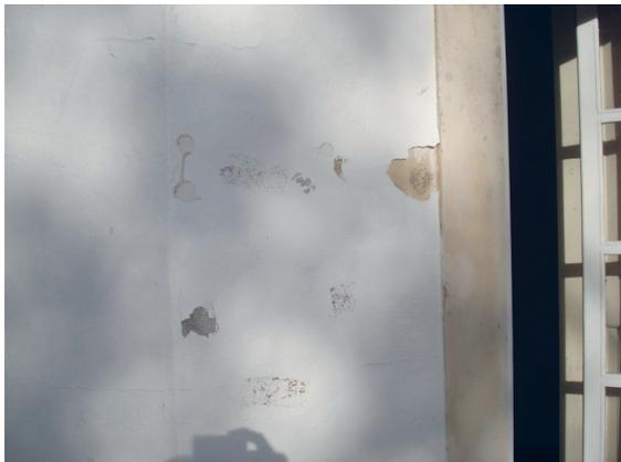
**Foto 14 – Degradação de fachadas do edifício devido á falta de isolamento (tinta)**
