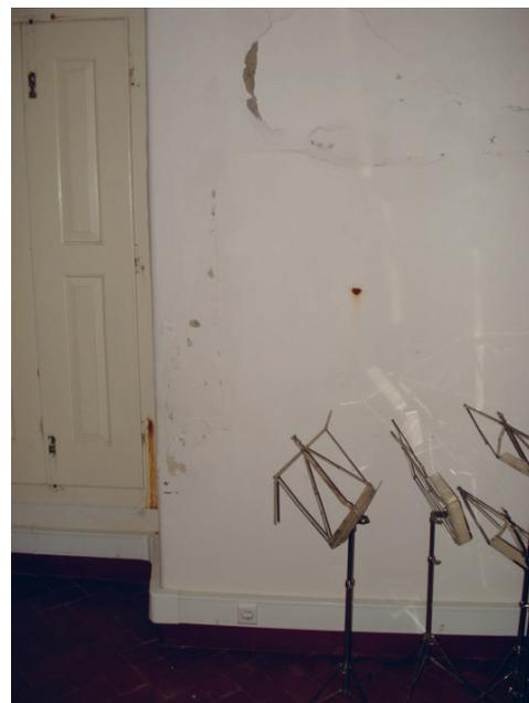
**Foto 8 – Descasque de rebocos interiores devido a infiltrações.**
