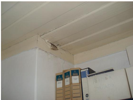
**Foto 6 – Tectos Interiores – Rotura parcial de forro em madeira por consequência de cedência da estrutura – Origem de infiltrações pela cobertura.**
