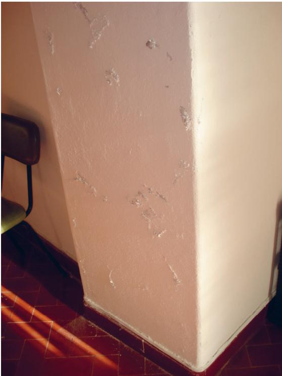
**Foto 10 – Paredes com salitre devido a humidade ascensional por capilaridade**
