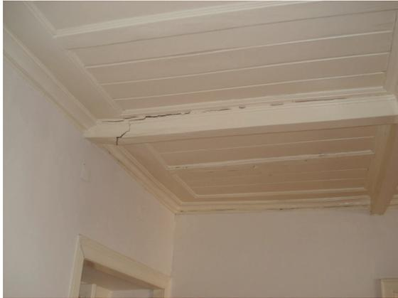
**Foto 5 – Tectos Interiores – Rotura parcial de viga, estando em risco a rotura total**
