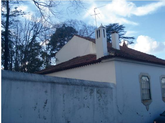
**Foto 13 – Degradação dos muros e fachadas do edifício devido á falta de isolamento (tinta)**
