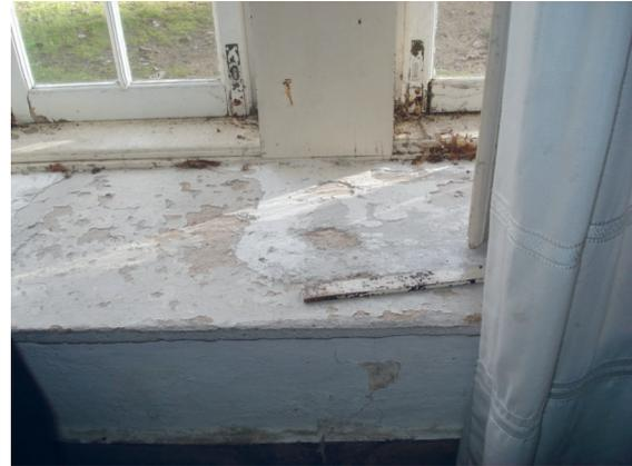
**Foto 11 – Degradação das caixilharias de madeira permitindo a penetração de água para o interior do edifício**
