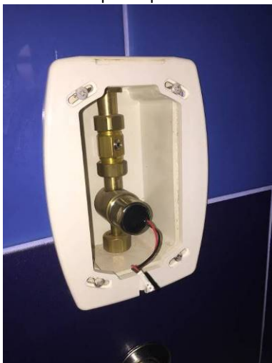
Fluxómetros existentes
