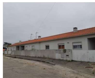
Bairro Social de Ortigosa UF de Souto da Carpalhosa e Ortigosa
