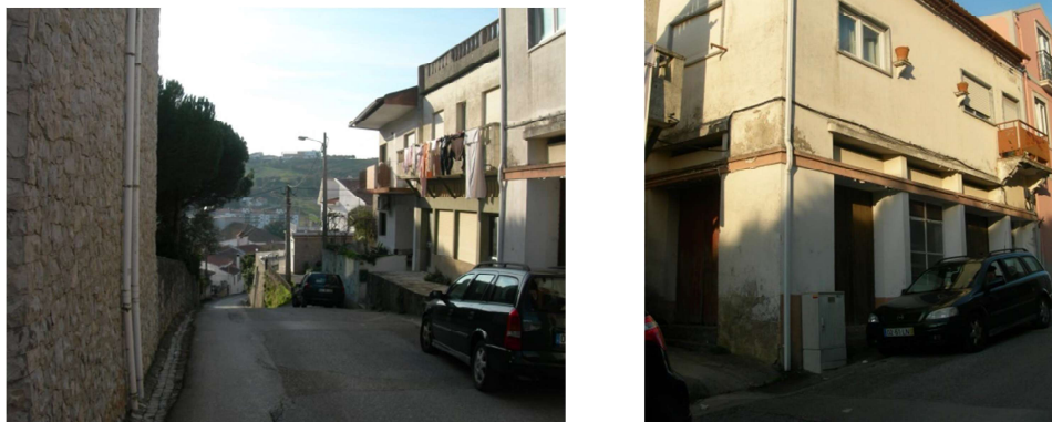
Figura 14. Construções com impacto negativo na Rua Xavier Cordeiro
