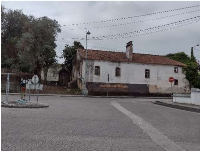
Figura 18 casa rural à entrada da vila
