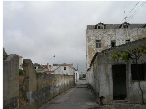
Figura 15 Rua das Pomelas – vista do tardo da antiga pensão Montanha
