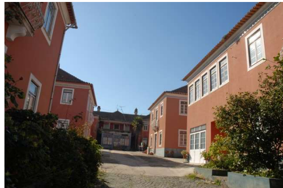
Figura 5. Conjunto edifícios rosa
