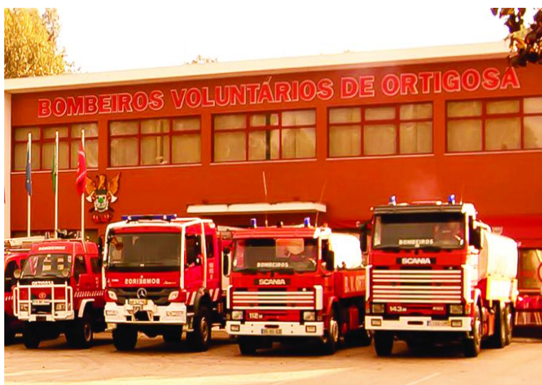
Figura 17: Fachada do Edifício Sede dos Bombeiros Voluntários de Ortigosa
