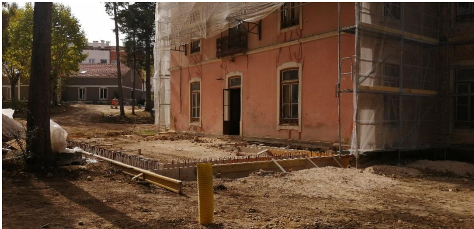
Foto 17 - Construção da base da cafetaria.
