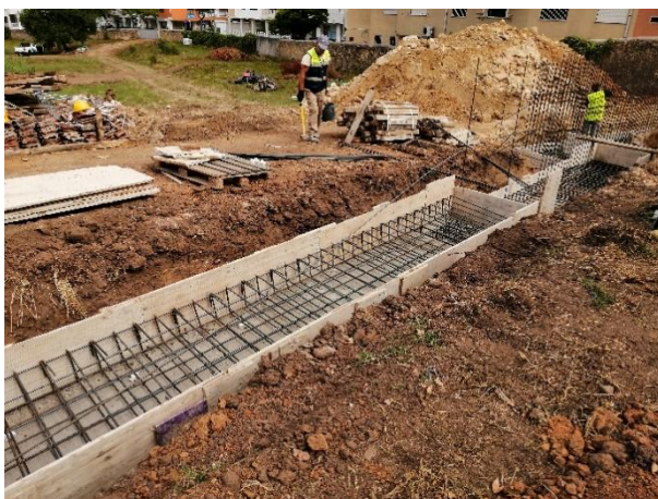
Foto 8 - Construção de muro tardoz e dos módulos de Instalações sanitárias, arrumos e apoio wifi .
