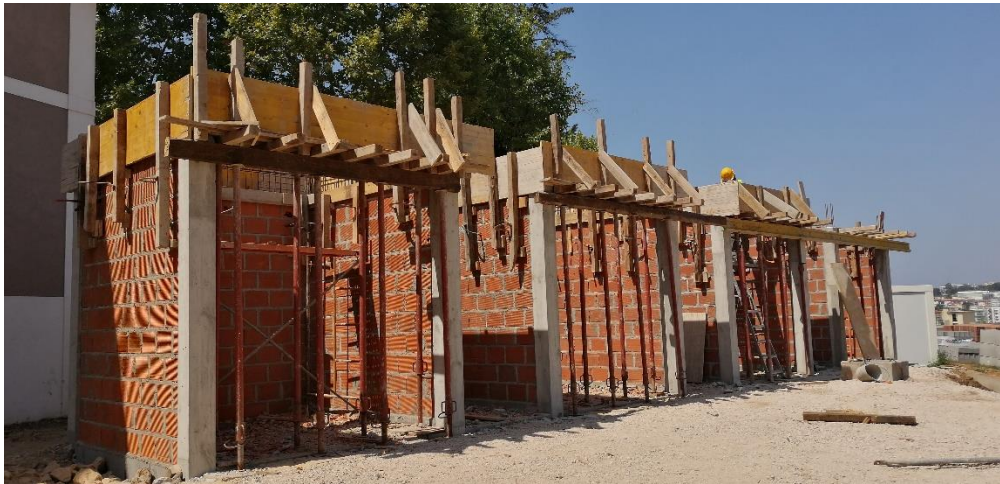
Foto 9 - Início do reforço estrutural do edifício A.
