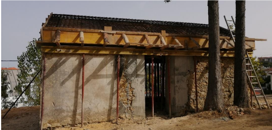
Foto 19 - Consolidação do Edifício D – miradouro.
