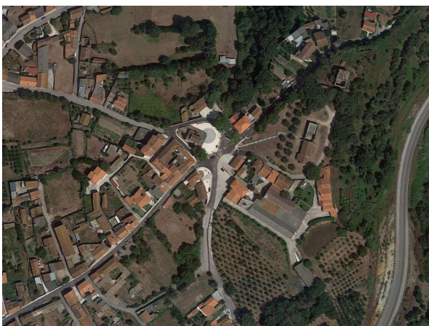
Figura 9 – Vista aérea do núcleo antigo de Monte Real
