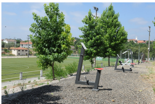
Instalação de ginásios ao ar livre para a prática de desporto informal Instalação de equipamento desportivo—campo relvado sintético
