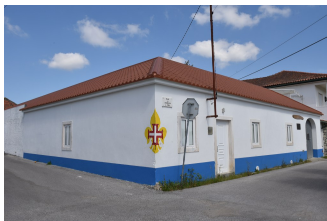
Substituição da cobertura do Centro de Juventude de Amor
