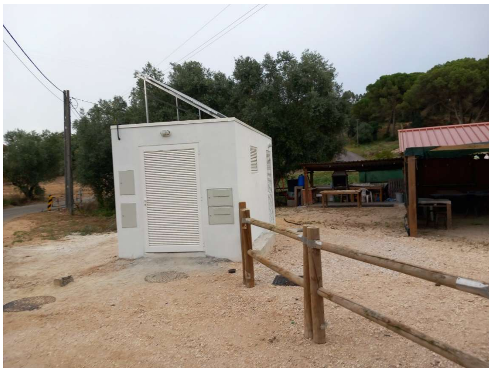
Aspetto da EEAR Freiria
