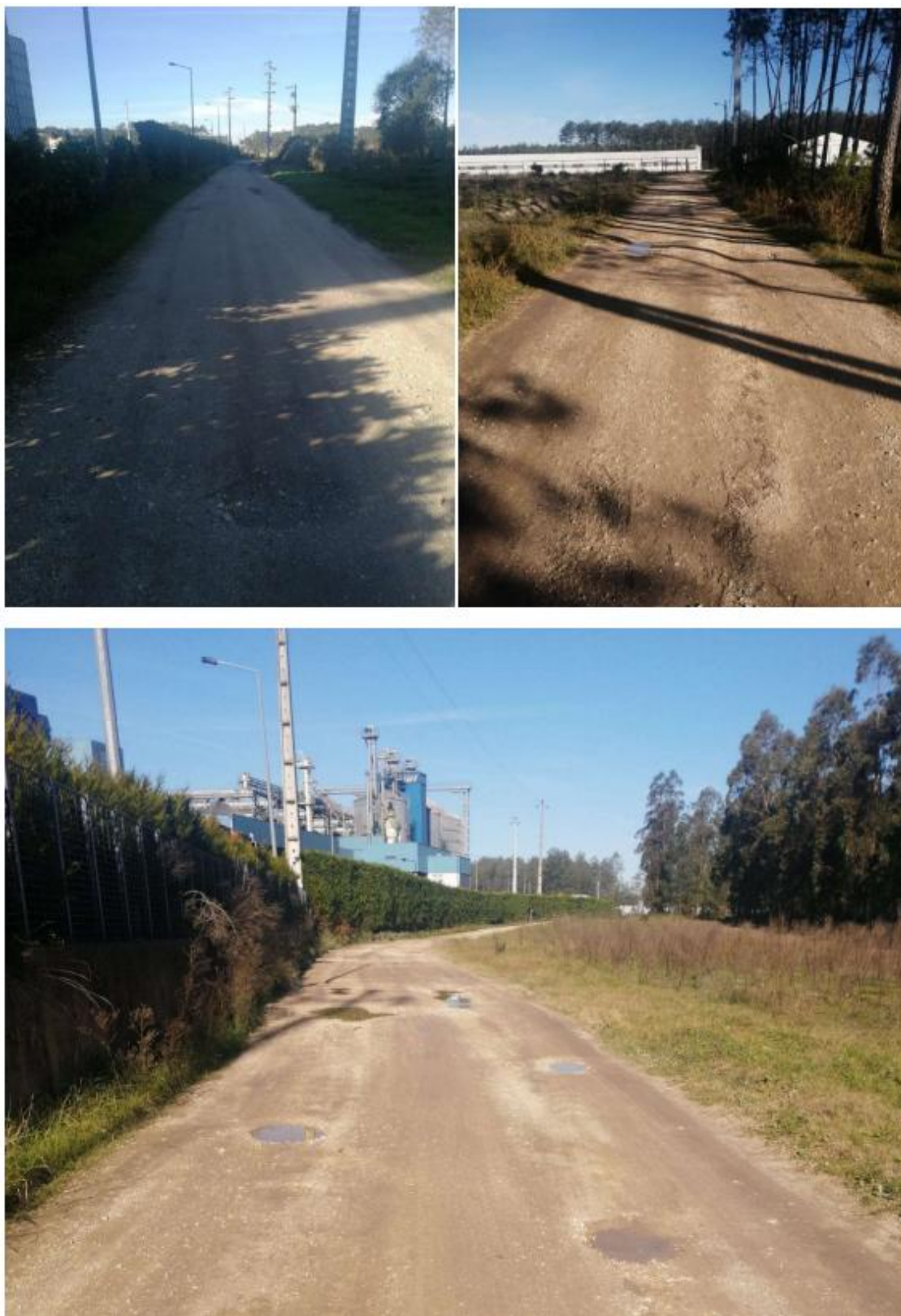
Figura 8, 9 e 10 – Registo fotográfico atual dos acessos à Instalação Avícola
