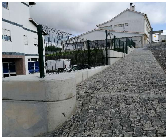
Foto 10: Muro de Suporte - Arrabal
