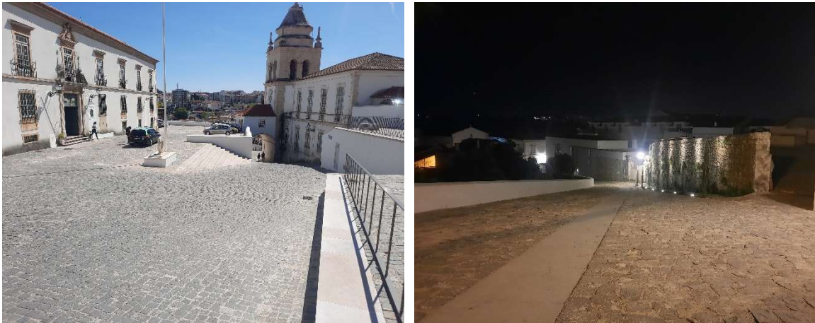
Fotos 52 e 53: Largo de São Pedro - Arranjos Exteriores da área envolvente ao castelo e principais acessos
