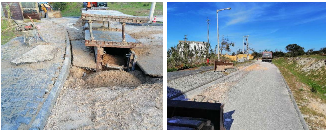
Fotos 27 e 28: Rua da Vala
