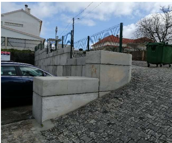
Foto 9: Muro de Suporte - Arrabal
