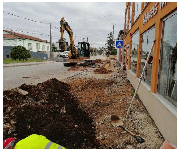
Foto 18: Rua do Vale
