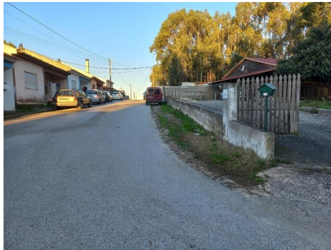
Figura 2 - Berma do lado direito da Rua do Chão Direito até ao início do coletor pluvial.
