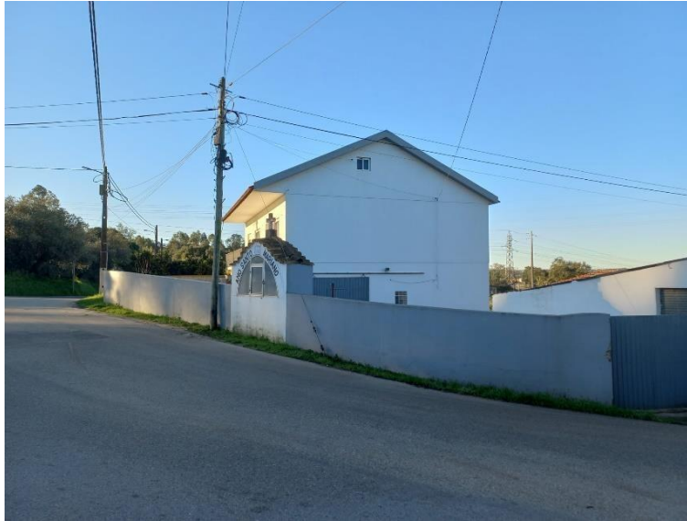
Figura 7 - Berma em calçada
