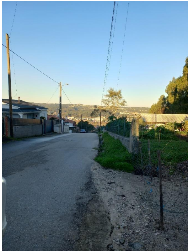
Figura 3 - Início do coletor pluvial e do passeio.
