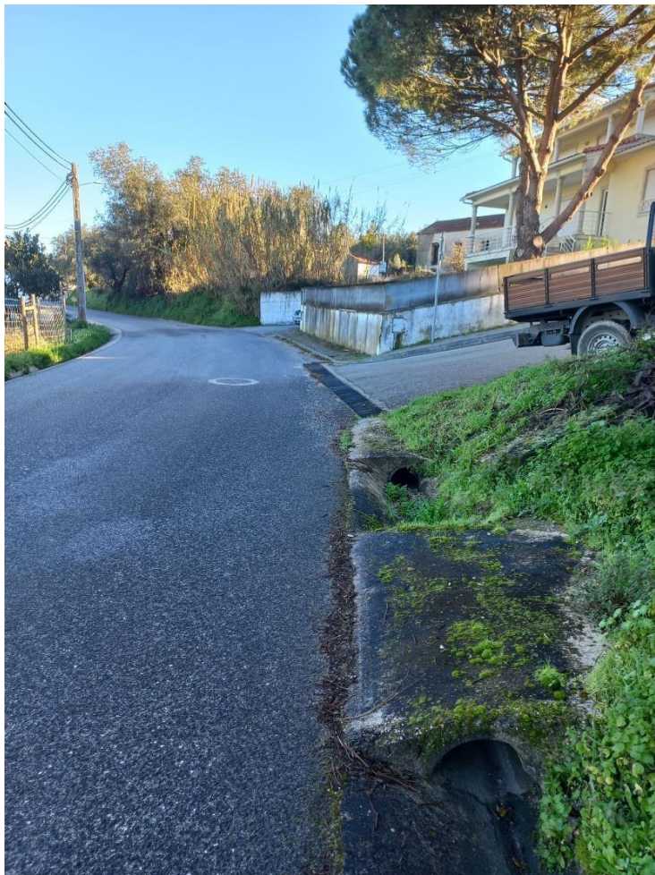
Figura 9 - Coletor e canaleta na Rua da Mina
