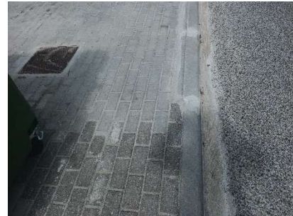
Figura 31 - Limpeza, reparação e reposição de caixas caixas de visita e sumidouros
