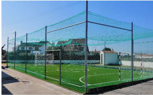
Figura 59 - Centro Escolar - vedação no campo de futebol
