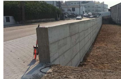
Figura 56 - Reforço de Circulação na Rua da Carreira de Tiro
