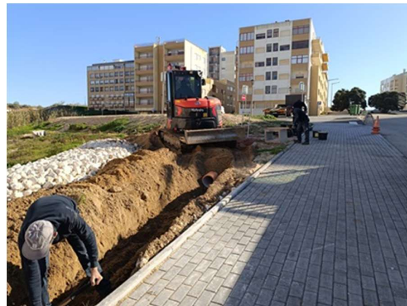
Figura 24 - Requalificação de coletor pluvial e talude Rua José Gaspar - Pedrógão
