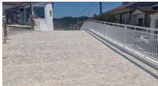
Figura 85 - Trabalhos de Pavimentação em calçada grossa
