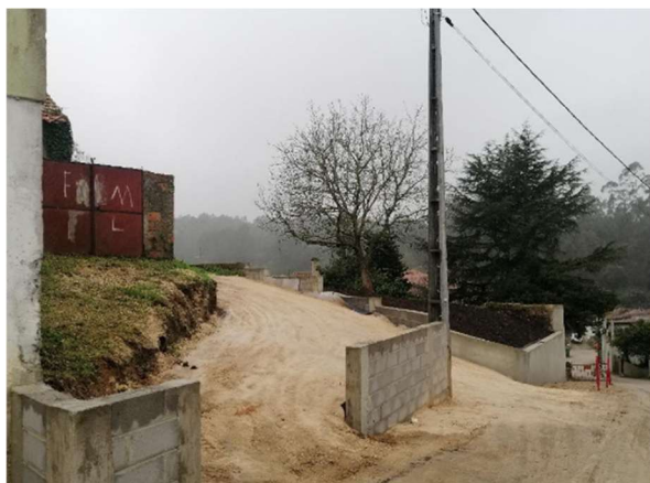
Figura 40 - Requalificação da Rua Nossa – Freixial
