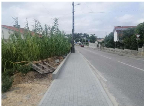
Figura 51 - Rua dos Cordeiros - Ponte da Pedra
