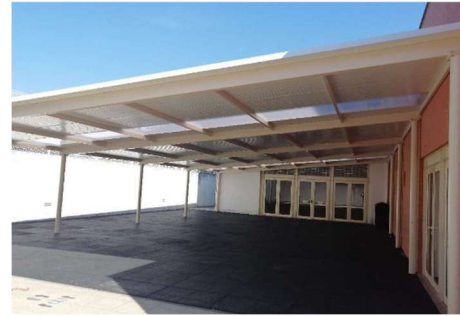
Figura 60 - Centro Escolar - Execução de cobertura
