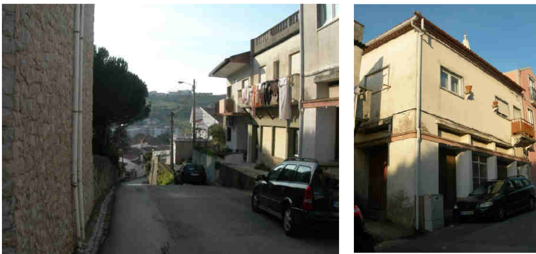
Figura 16. Construções com impacto negativo na Rua Xavier Cordeiro
