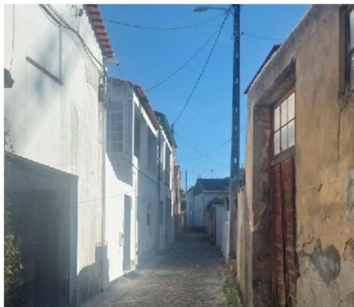
Figura 16 Vista de uma das transversais entre a Rua de Leiria e a Rua dos Arrabaldes
