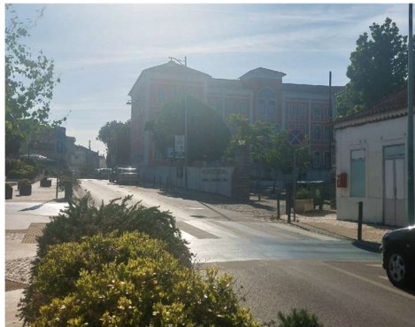
Figura 12 Vista do Hotel das termas desde o largo
