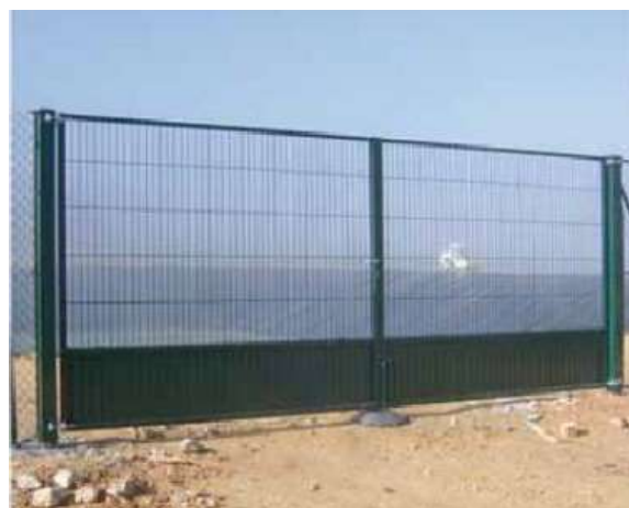
Figura 7: Portão de acesso ao parque
