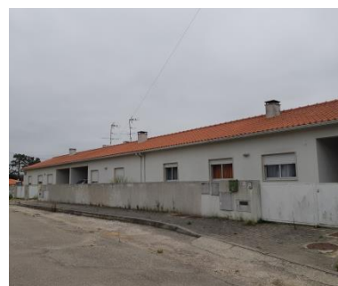
Bairro Social de Ortigosa UF de Souto da Carpalhosa e Ortigosa
