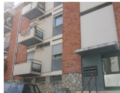
Rua João XXI (habitação isolada) UF de Leiria, Pousos, Barreira e Cortes
