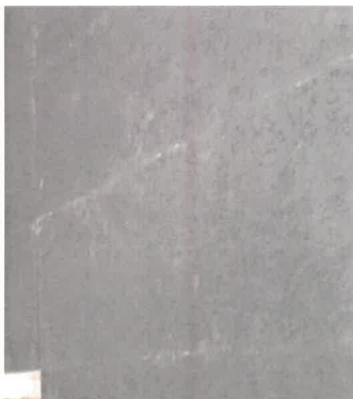
Foto08 - amostra do revestimento em placas Knauf Organic, na sala de ensaios
