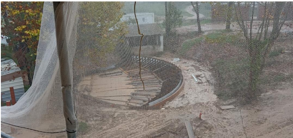
Figura 11 - Cofragem do muro do Lago (interior).
