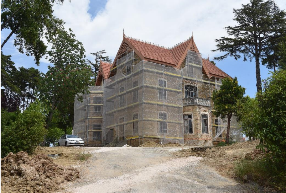
Figura 14 – Intervenções no exterior do Edifício A.
