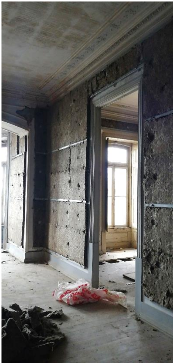
Figura 23 - Isolamento térmico
