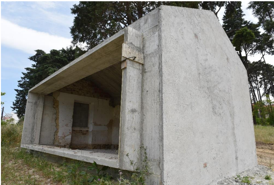
Figuras 72 e 73 – Trabalhos no Edifício D.
