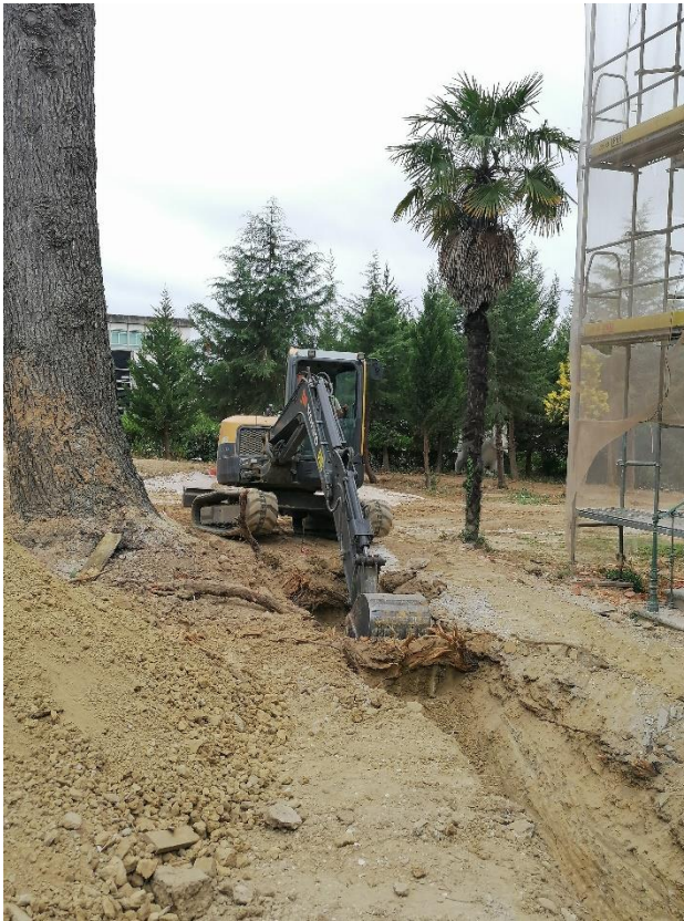
Figura 3 - Instalação de tubagens de esgotos.
