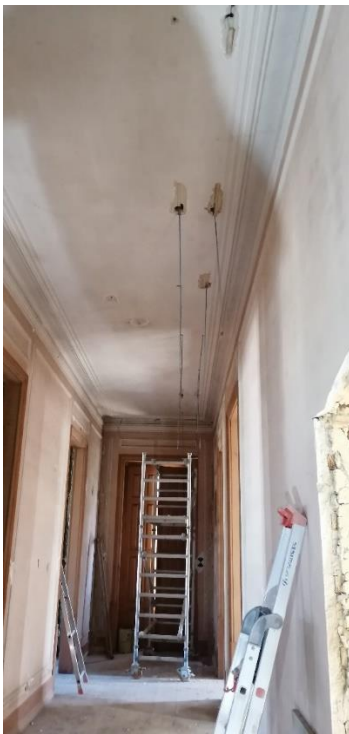
Figuras 25 e 26 - Preparação para esteiras e reforço com tarugos.
