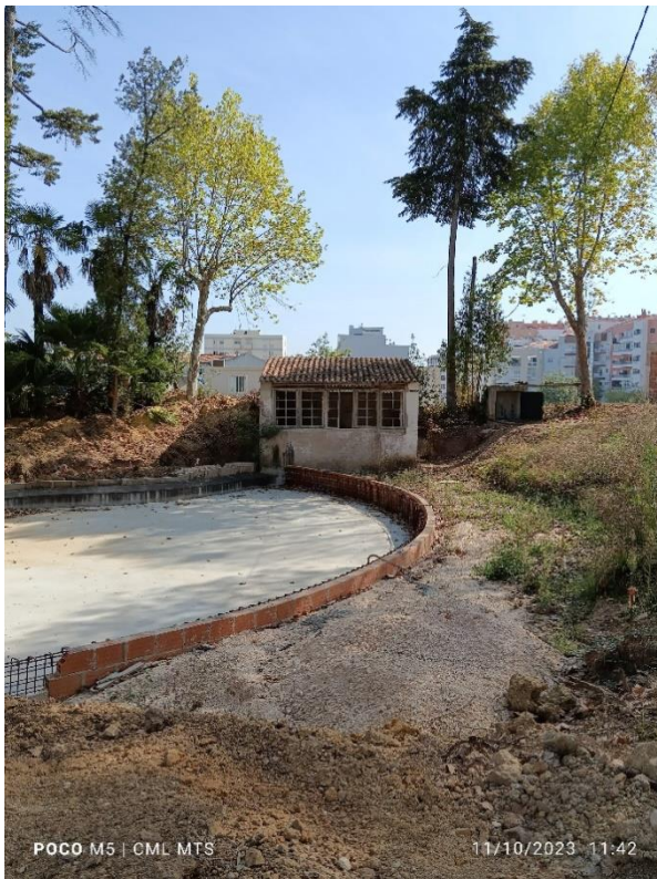
Figuras 8, 9 e 10 – Betonagem no Lago.
