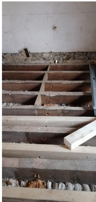
Figuras 21 e 22 - Furação das vigas e passagem dos tirantes
