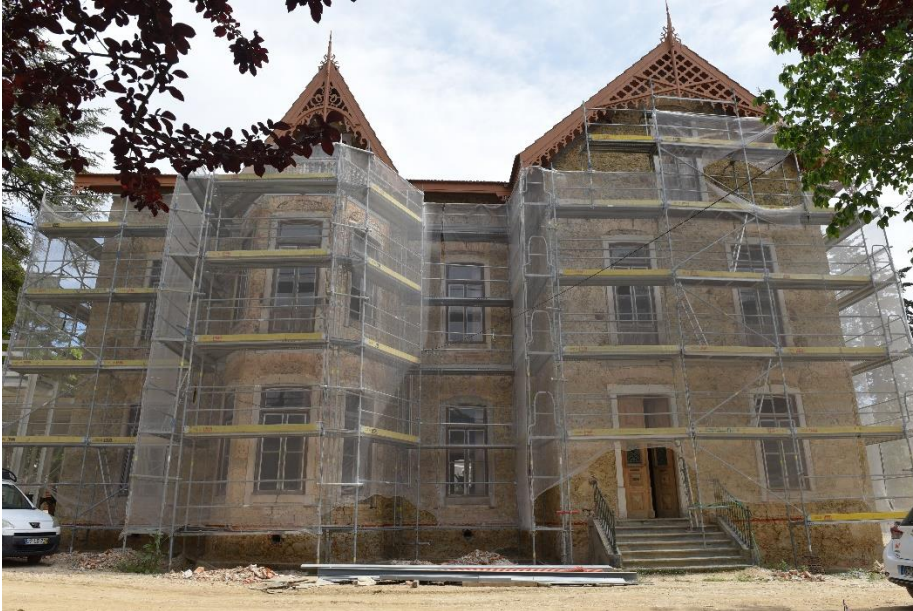
Figura 15 – Fachada com a entrada principal para o Edifício A.
