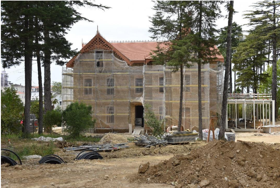
Figura 16 – Fachada posterior e vista da estrutura da zona da cafetaria.
