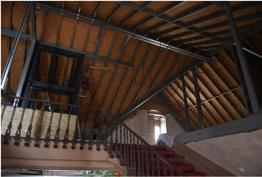
Figuras 40 a 56 – Trabalhos executados no Interior do Edifício A até maio.
