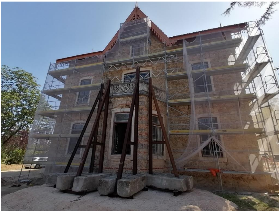
Figura 57 - Reforço estrutural da baywindow poente.
