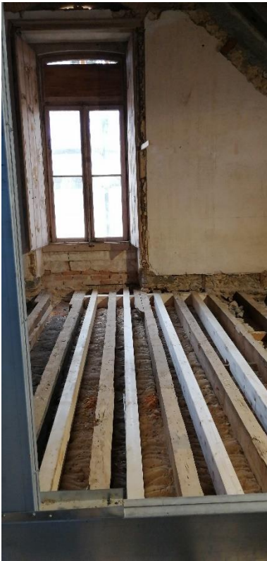
Figura 20 – Trabalhos no interior - Reforço da laje da UTA, Piso 2
