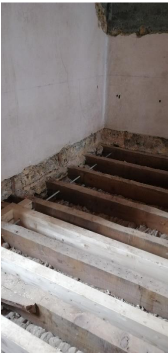
Figuras 21 e 22 - Furação das vigas e passagem dos tirantes
