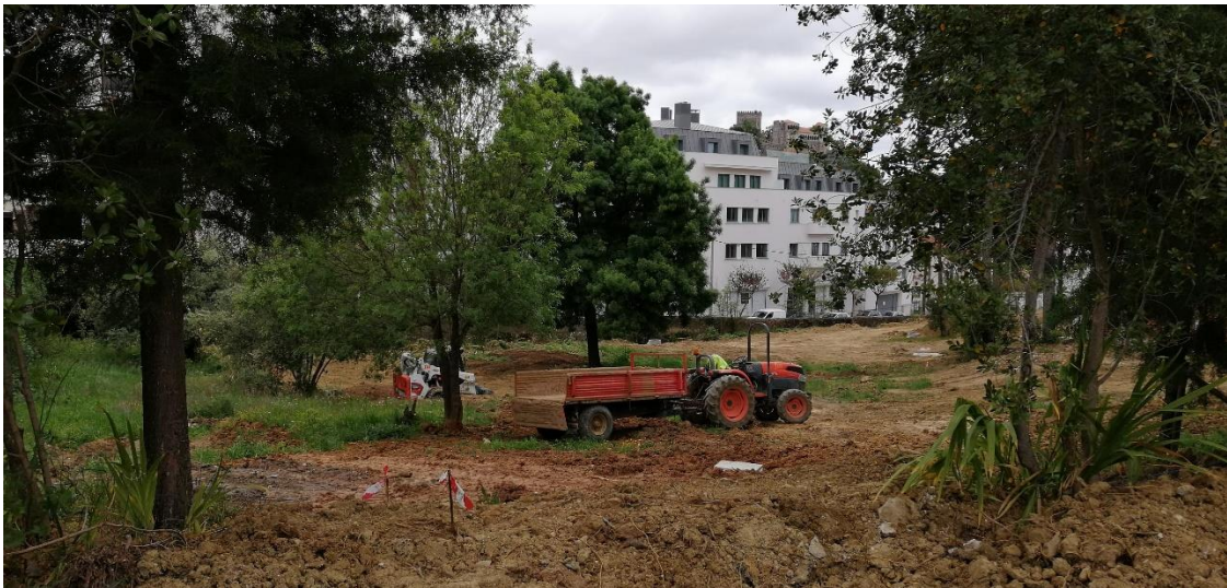
Figuras 1 e 2 - Trabalhos de terraplanagens na área exterior.
