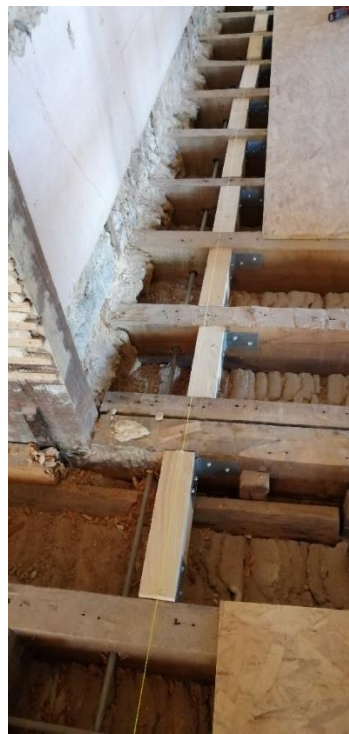
Figuras 25 e 26 - Preparação para esteiras e reforço com tarugos.
