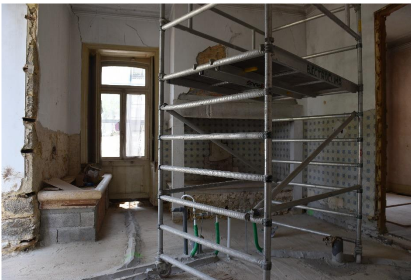
Figura 19 – Zona da cozinha.
