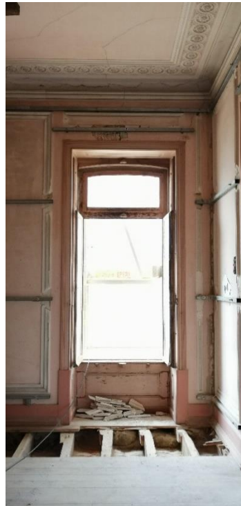
Figura 24 - Estrutura de suporte dos expositores
