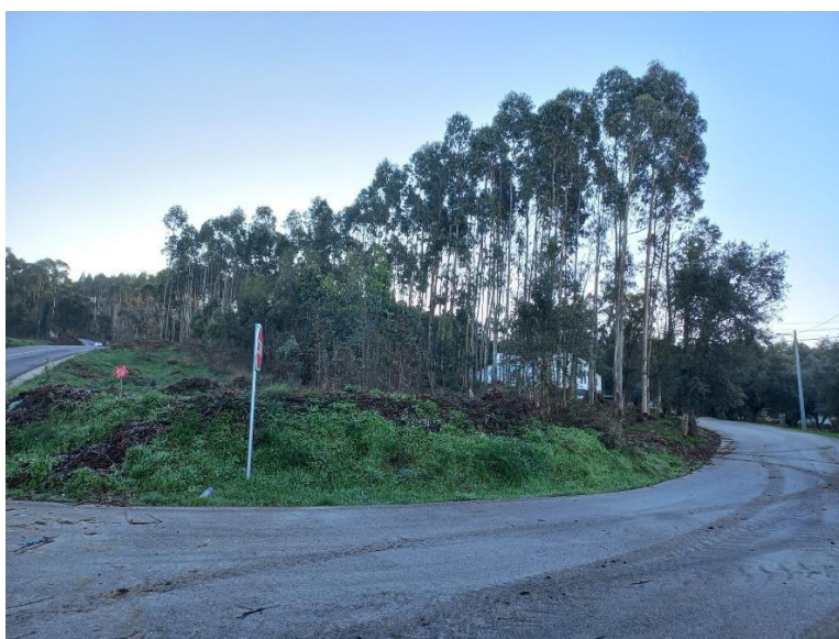
Figura 4 - Término do coletor e passeio no cruzamento com a Rua do Sr.
