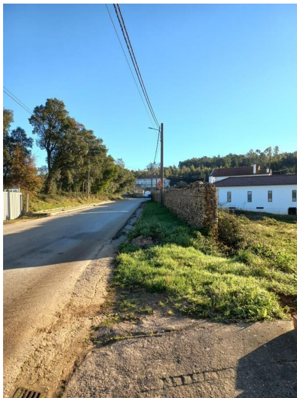
Figura 8 - Berma em calçada entre a valeta existente e o muro em pedra
