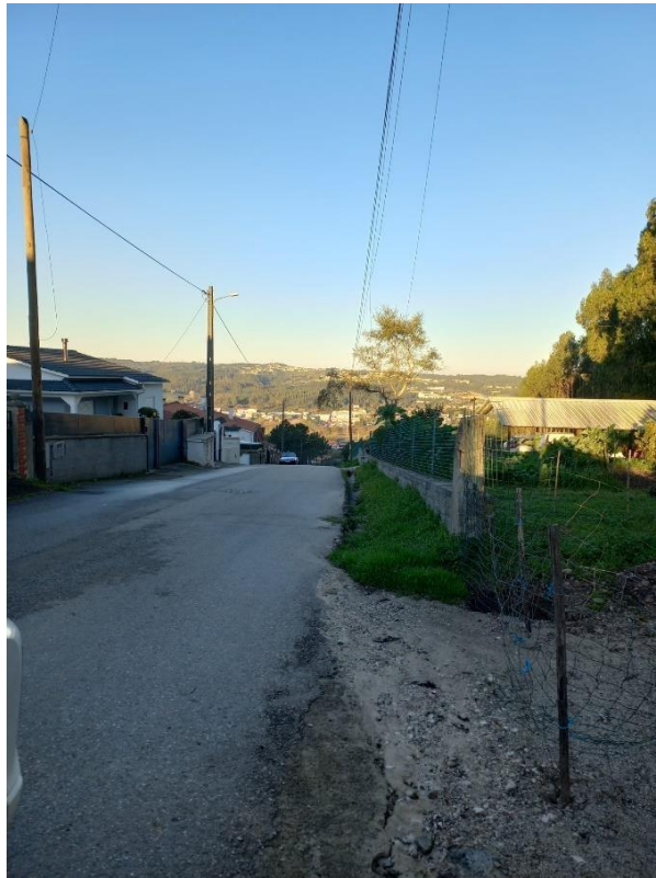
Figura 3 - Início do coletor pluvial e do passeio.
