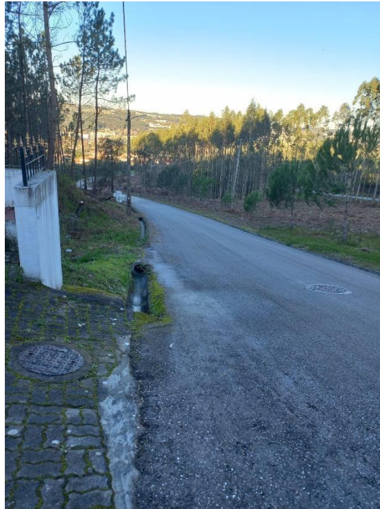
Figura 5 - Início do coletor pluvial
