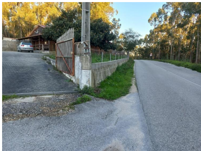
Figura 1 - Berma na confrontação da moradia de madeira com a Rua do Sr
