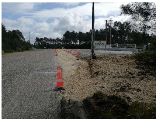
Fig. 3: ABGE em zonas de abertura de caixa
