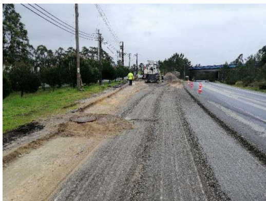
Fig. 1: Abertura de caixa e fresagem de camadas betuminoso
