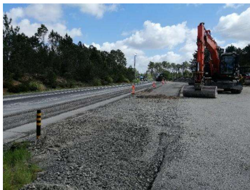
Fig. 2: ABGE em zonas de abertura de caixa
