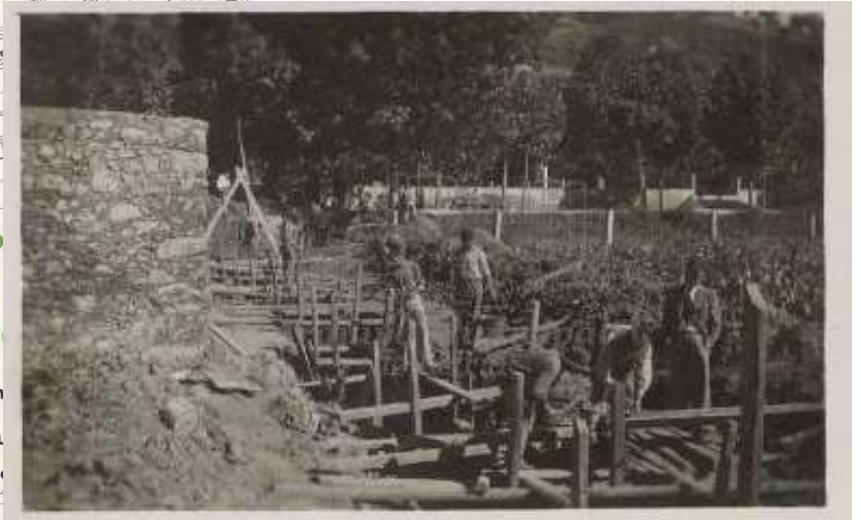
Início da construção da Rodoviária, 1960 [Arquivo Municipal de Leiria]
