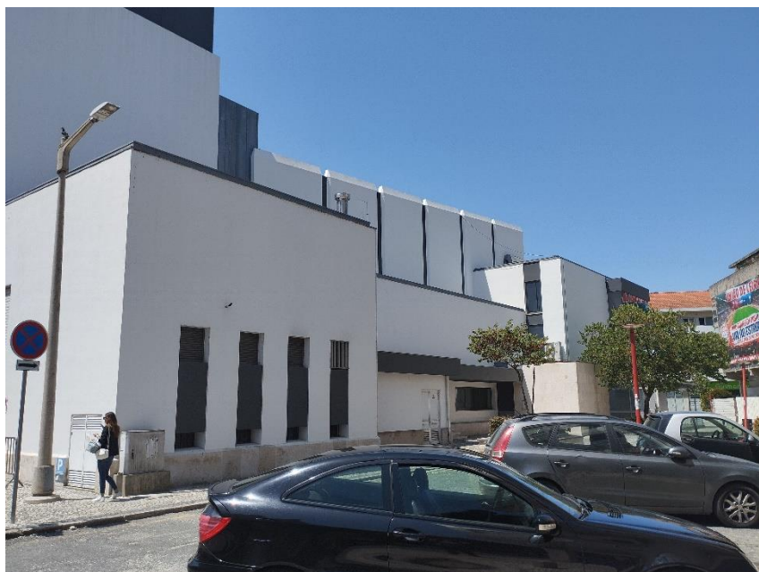
FIGURA 13 - EXTERIOR: FACHADA POSTERIOR, VISTA DA RUA AMÉRICO CORTEZ PINTO.
