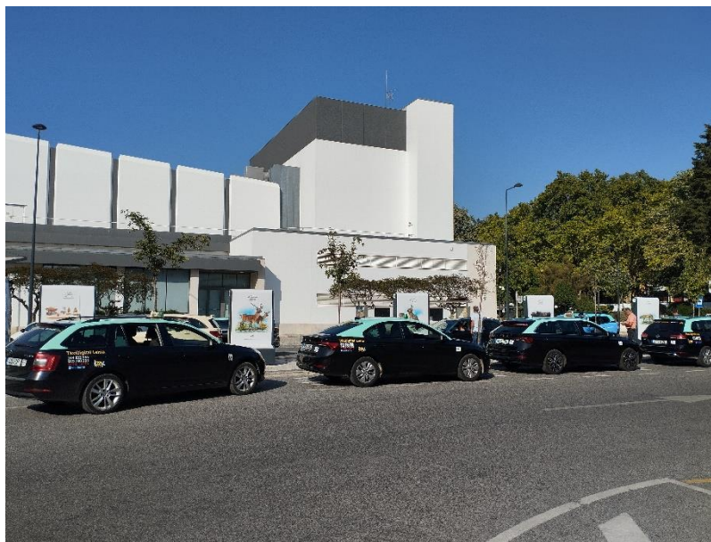
FIGURA 3 – ENVOLVENTE: PRAÇA DE TÁXIS, DEFRENTE DA FACHADA PRINCIPAL DO TJLS.
