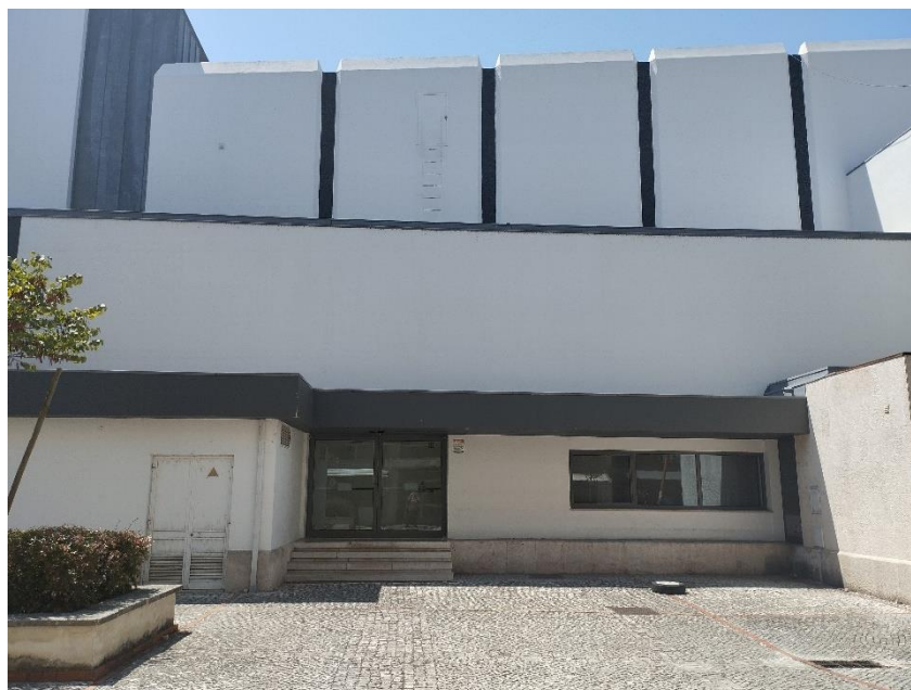
FIGURA 12 - EXTERIOR: FACHADA POSTERIOR – ENTRADA PARA ÁREAS TÉCNICAS.
