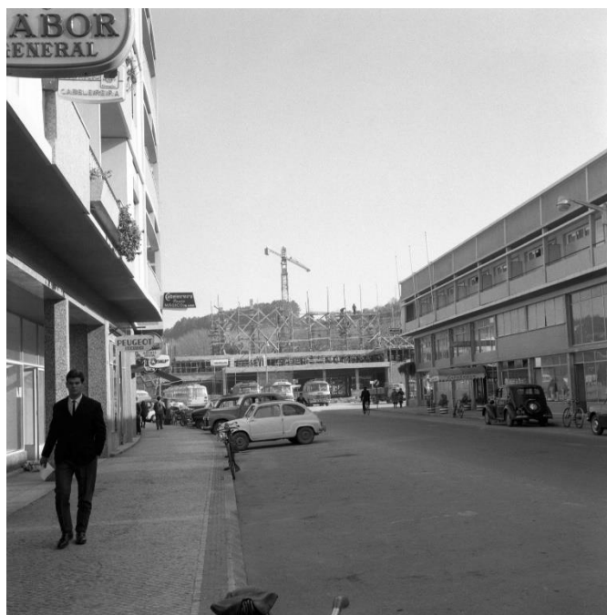
FIGURA 22 – A AVENIDA HERÓIS DE ANGOLA E O TEATRO JOSÉ LÚCIO DA SILVA EM CONSTRUÇÃO. FONTE: TJLS.
