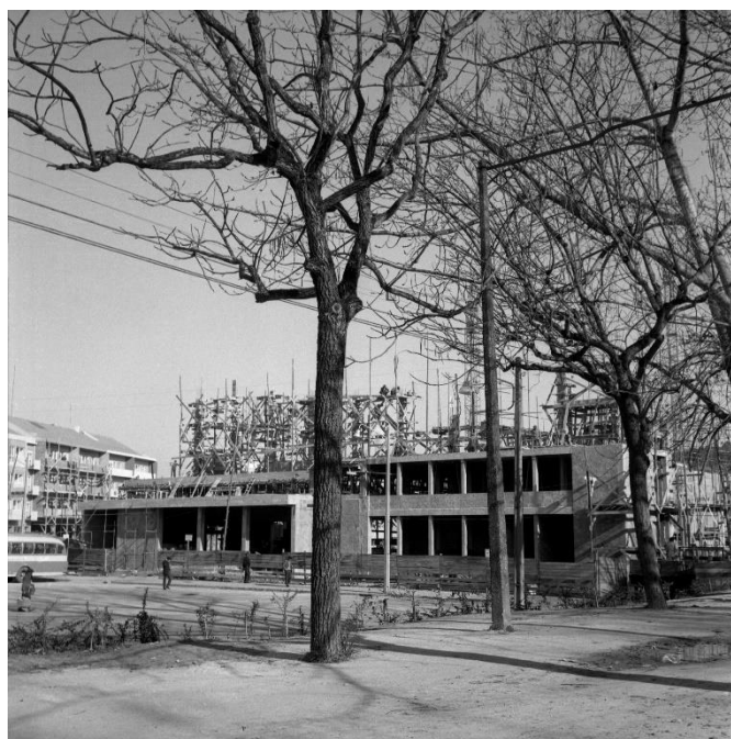
FIGURA 23 – PORMENOR DO TEATRO JOSÉ LÚCIO DA SILVA EM CONSTRUÇÃO. FONTE: TJLS.
