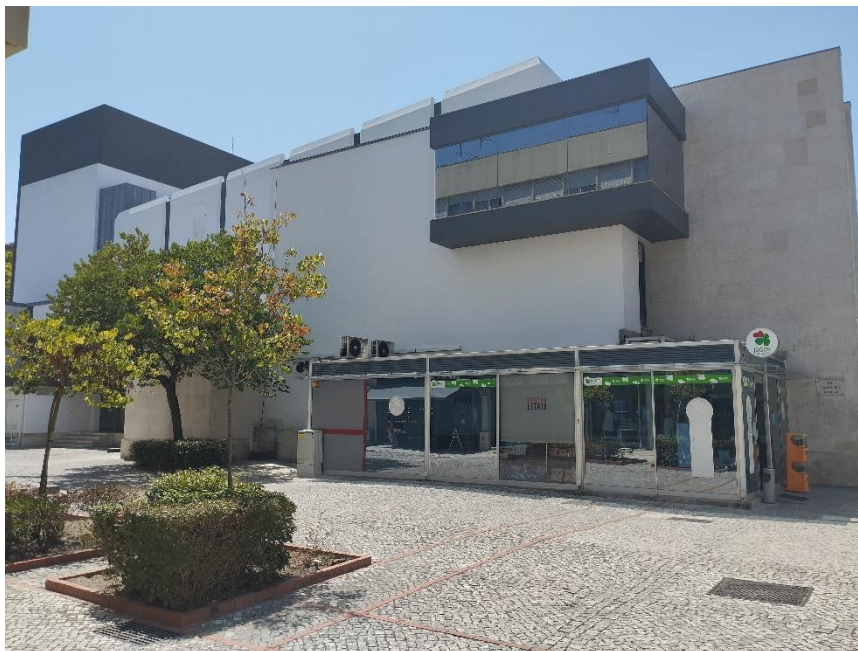
FIGURA 11 - EXTERIOR: FACHADA POSTERIOR, NA RUA MARIA DA GRAÇA LÚCIO DA SILVA, COM PORMENOR DO QUIOSQUE ADOSSADO.
