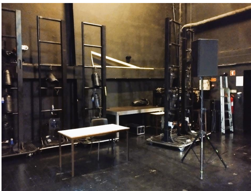
FIGURA 54 – INTERIOR: PORMENOR DOS BASTIDORES DO PALCO.
