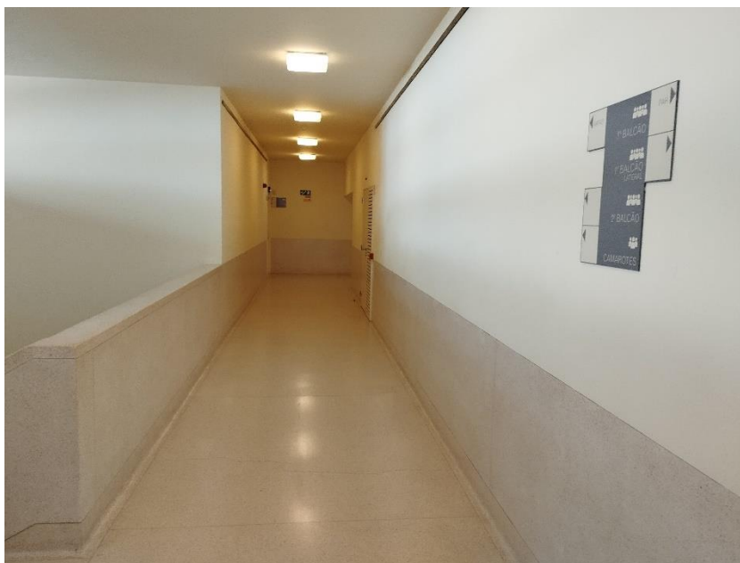
FIGURA 33 – INTERIOR: CORREDOR DE ACESSO AO 1.º BALCÃO E CAMAROTES, NO PISO 1.
