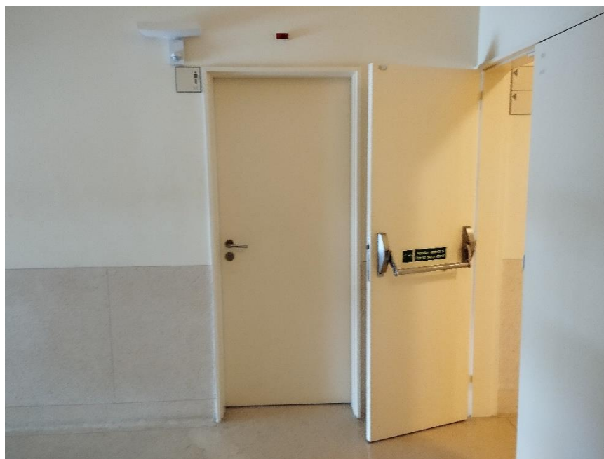
FIGURA 46 – INTERIOR: INSTALAÇÕES SANITÁRIAS NO PATAMAR DE ACESSO AO PISO 2.
