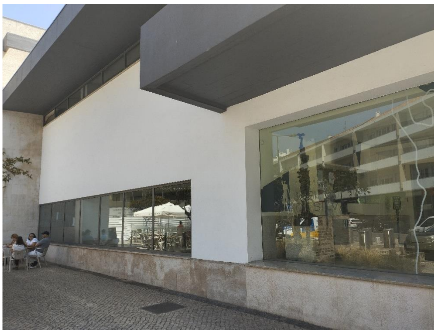
FIGURA 10 - EXTERIOR: FACHADA LATERAL ESQUERDA – PORMENOR DOS VÃO E JANELAS.
