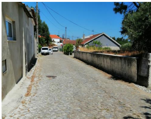
Foto01- estado do muro existente
