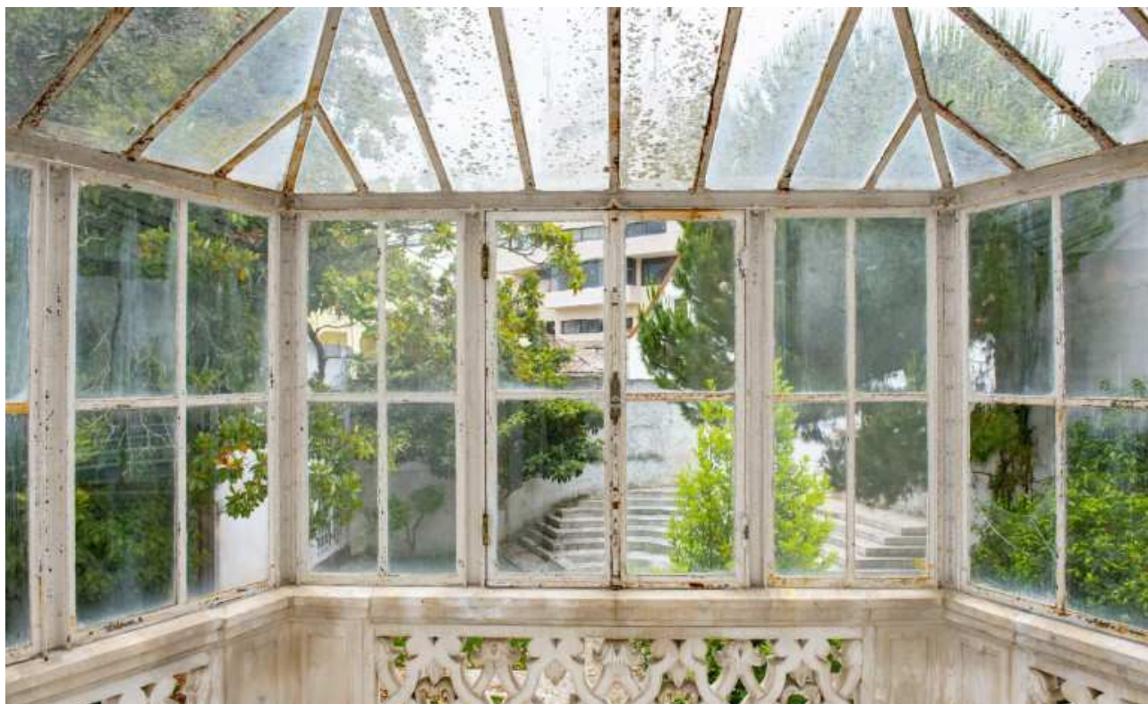
Fotografia 20 – Sala do Piso 1, virada para o logradouro.
