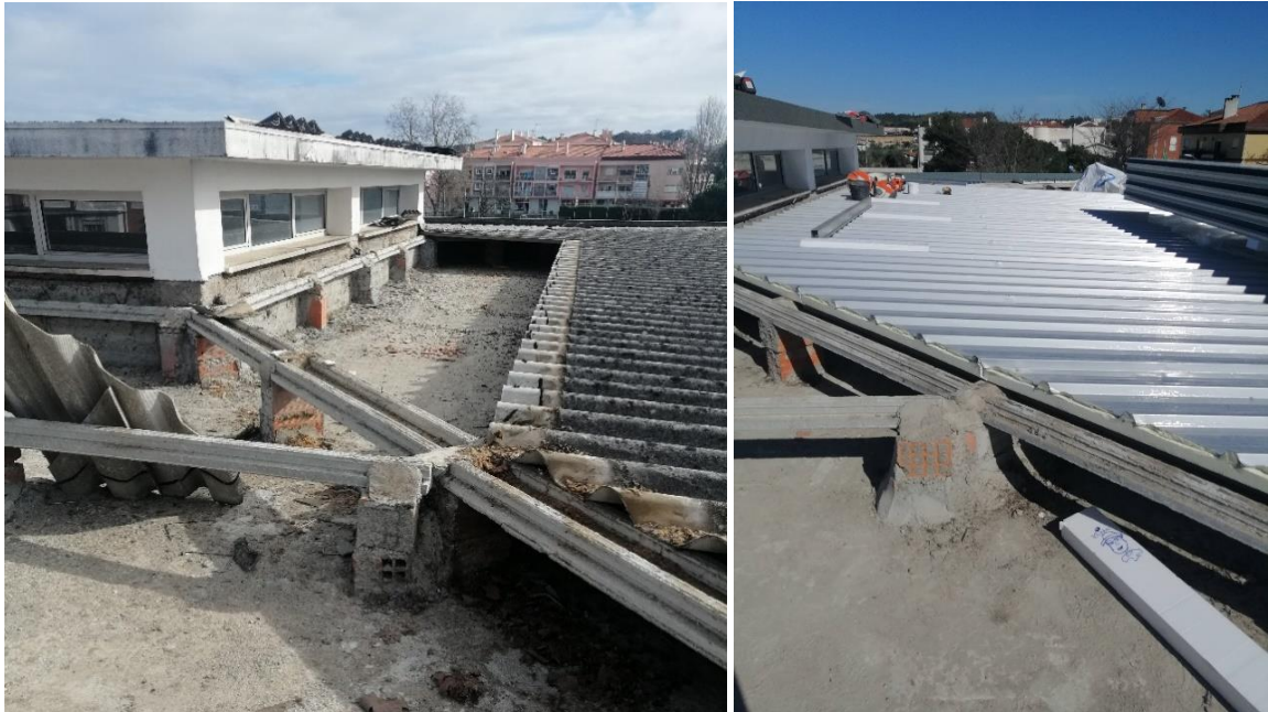
Local proposto para a implantação dos equipamentos (fotos tiradas durante as obras de remoção das coberturas em fibrocimento).
