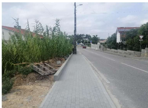
Figura 51 - Rua dos Cordeiros - Ponte da Pedra
