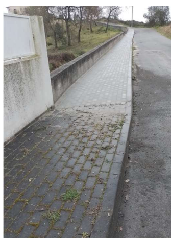
Figura 37 - Rua da Escola Velha
