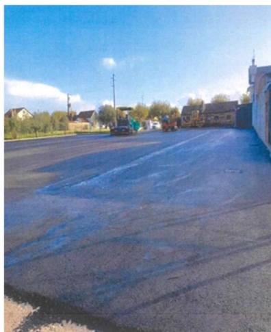
Figura 41 - Pavimentação do Largo dos 13, Bajouca
