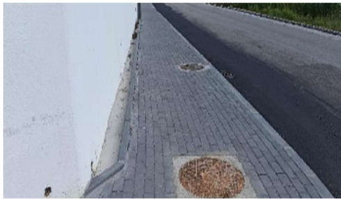
Figura 53 - Execução de passeios na Rua da Alegria, Guimarãesota
