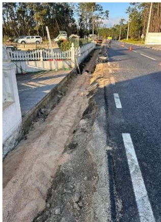
Figura 23 - Requalificação de coletor e valeta Rua Nossa Senhora de Fátima
