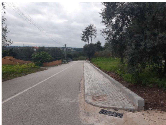
Figura 50 - Execução de Passeios, na Rua Senhor dos Milagres, Pingarelhos
