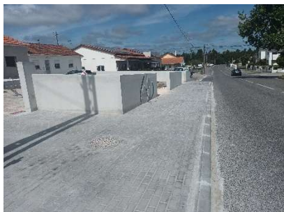
Figura 30 - Limpeza, reparação e reposição de de visita e sumidouros
