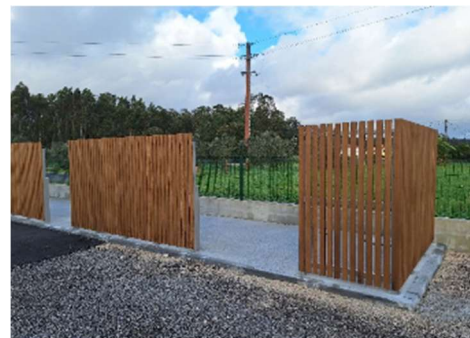
Figura 72 - vedação em madeira para os ecopontos na nova feira dos 13
