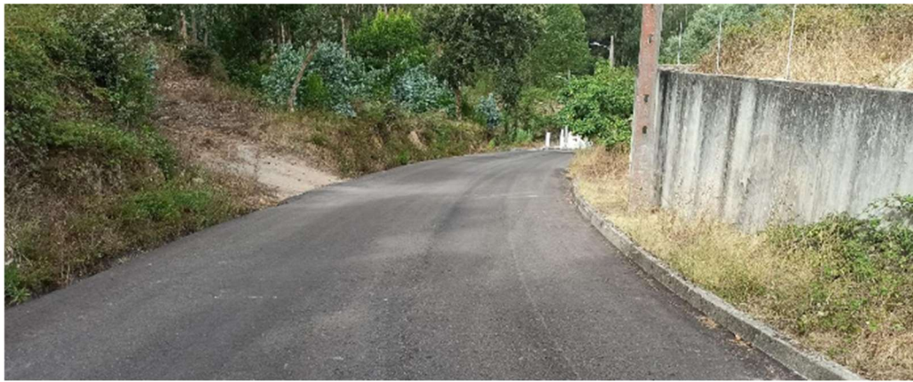
Figura 61 - Pavimentação da rua da Volta do Carro e rua Principal (parte), em Mouratos
