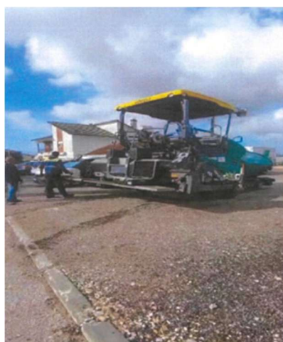
Figura 42 - Pavimentação do Largo dos 13, Bajouca
