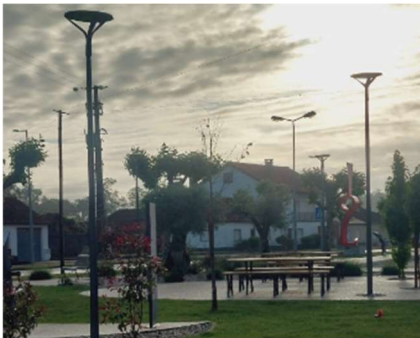
Figura 71 - Trabalhos de Iluminação no Jardim do Largo da Feira dos 13
