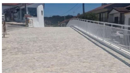
Figura 85 - Trabalhos de Pavimentação em calçada grossa
