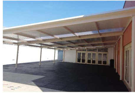
Figura 60 - Centro Escolar - Execução de cobertura
