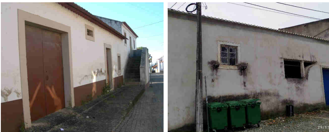
Figura 14. Casa de características rurais, com dependências
