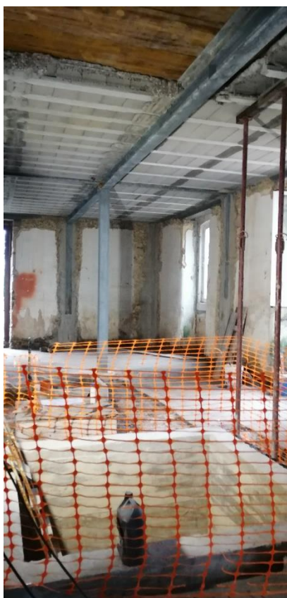
Foto 18 - Saneamento, base para laje de pavimento, caixa de elevador, eletrificação e AVAC (parcial).
