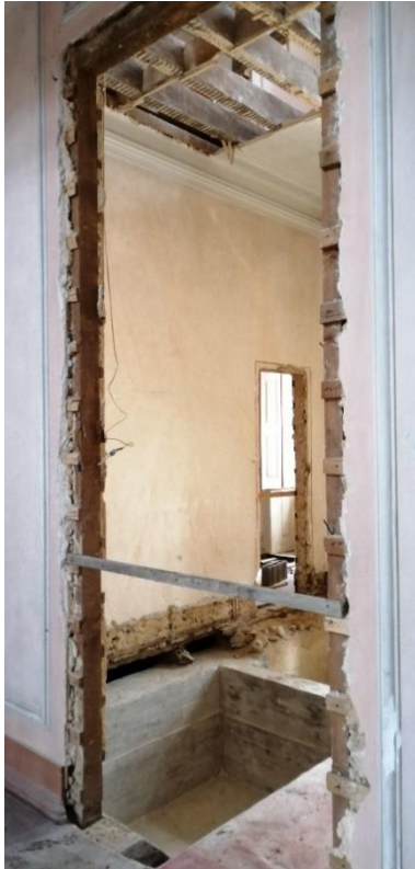
Fotos 10, 11, 12 e 13 - Preparação de base para elevadores.
