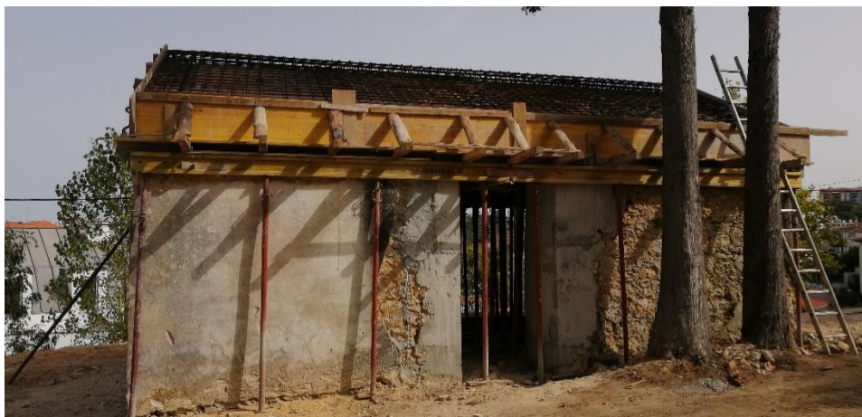
Foto 19 - Consolidação do Edifício D – miradouro.
