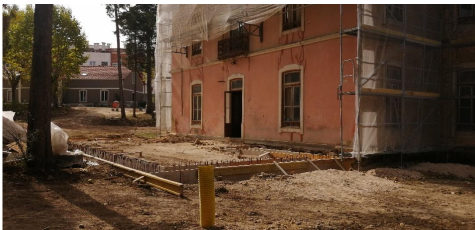
Foto 17 - Construção da base da cafetaria.
