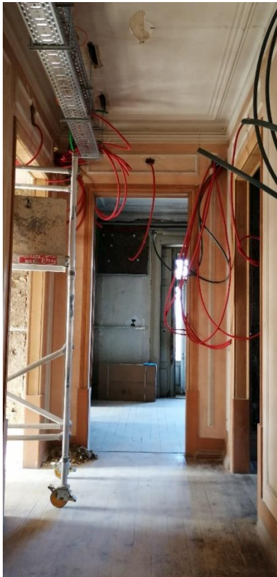
Fotos 14, 15 e 16 - Implementação de rede elétrica e de AVAC (parcial).
