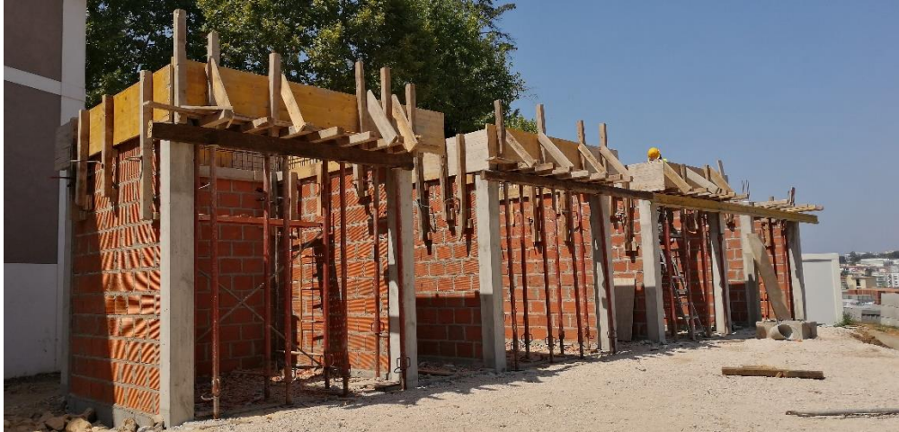
Foto 9 - Início do reforço estrutural do edifício A.
