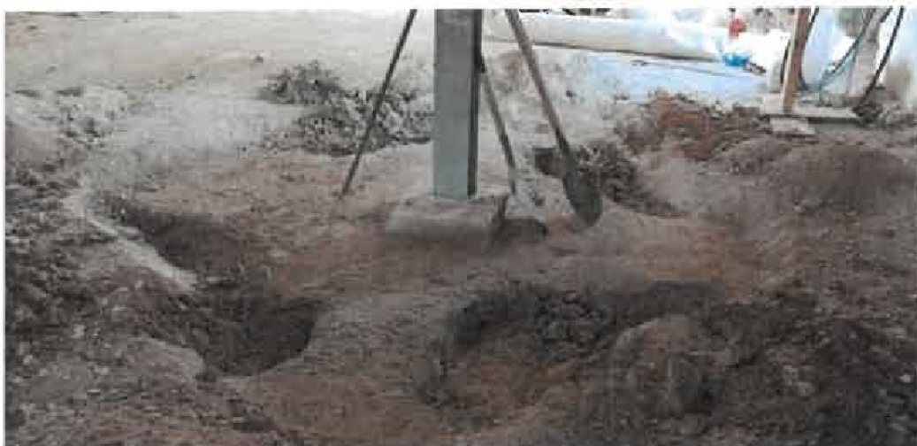
Laje térrea em terra batida
