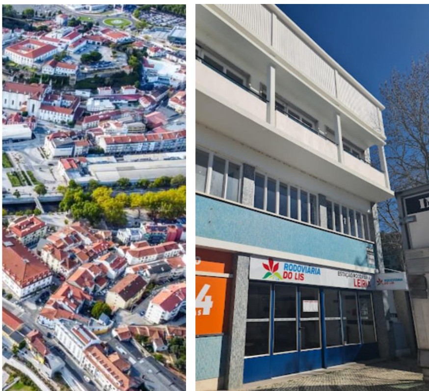
Fig. 1 e 2 – Foto aérea e foto da entrada de passageiros do terminal (fotos impulsiveaddiction com)
