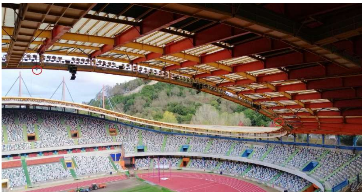
CAMARAS DE CCTV PARA BANCADA. 4 NA BANCADA POENTE, 4 NA BANCADA NASCENTE E 2 NA BANCADA SUL
