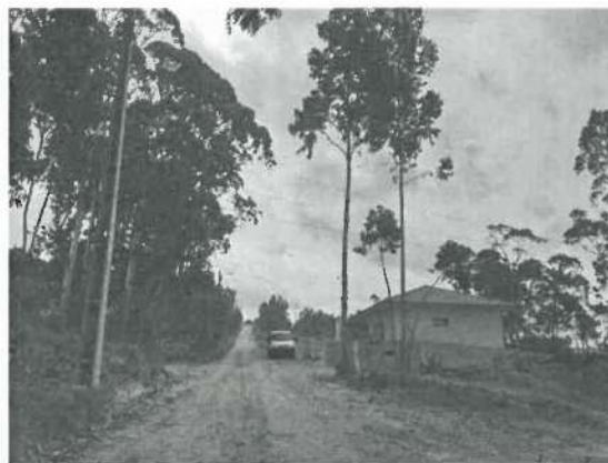
Fig. 2: Zona com camada de argila na base da estrutura
