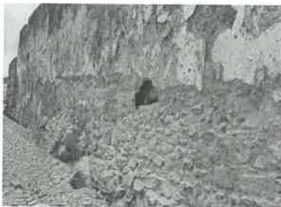
Foto 7 – Picagem do reboco com deteção de lacuna
