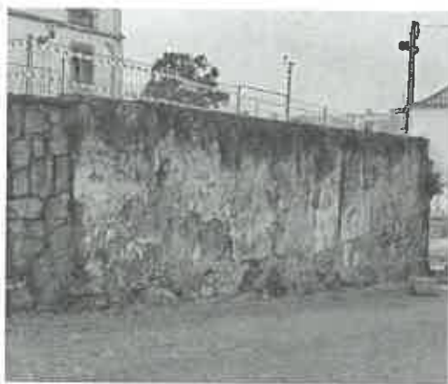
Foto 6 – Muro medieval antes da intervenção
