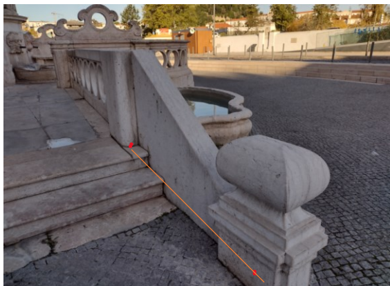
Vista da guarda do lado esquerdo da fonte
