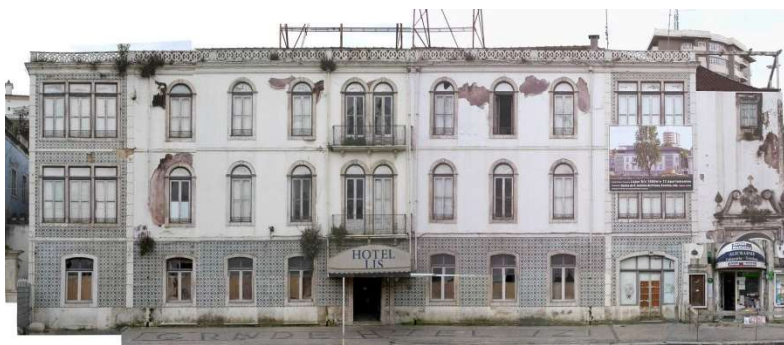
Figura 4. Imagem do hotel Liz antes da intervenção (proc. 935/07)
