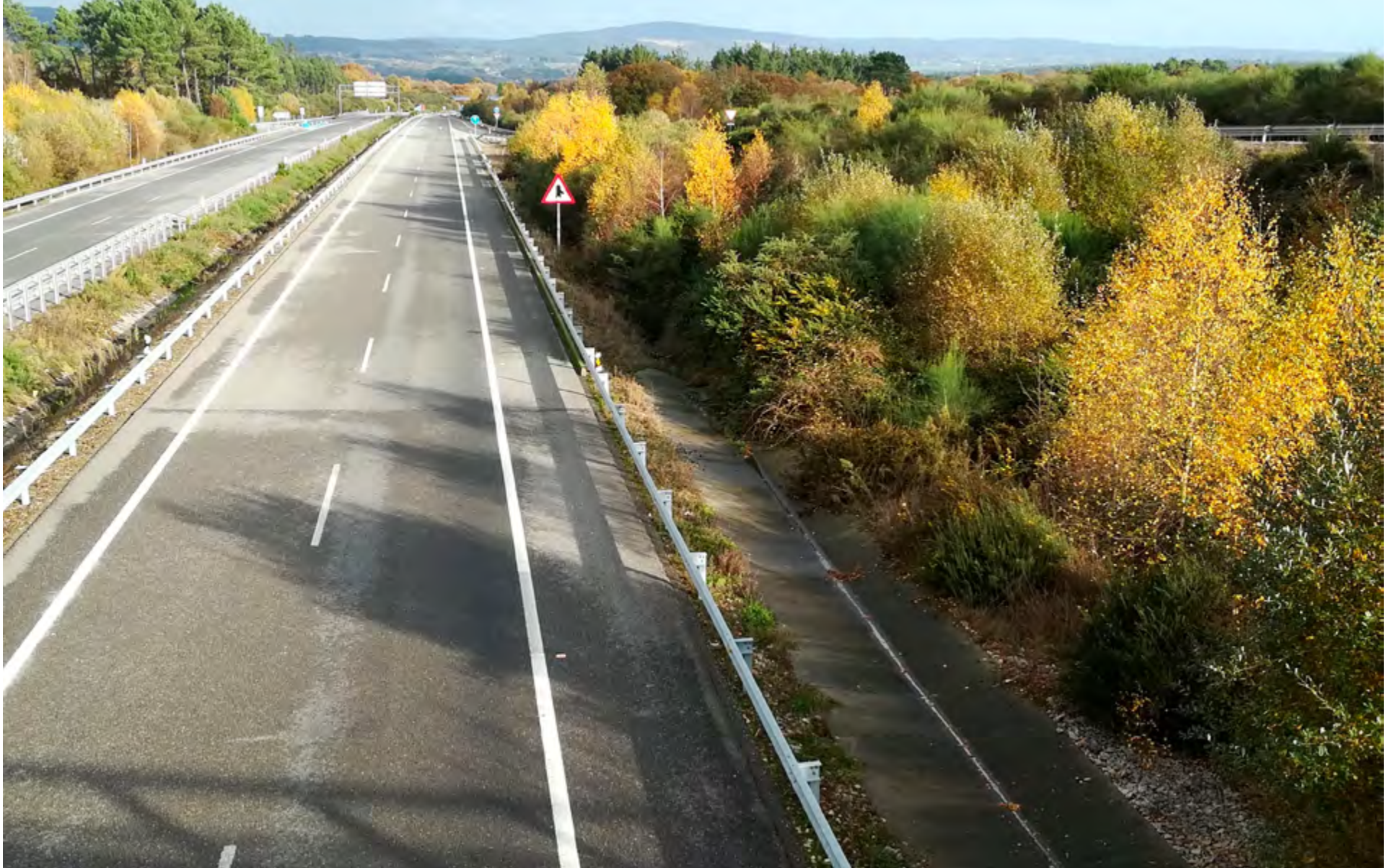
O planeamento adequado do tipo de vegetação que irá cobrir as margens das estradas e falsos túneis significa reduzir os custos de manutenção a longo prazo, evitando a proliferação de Cortaderia
