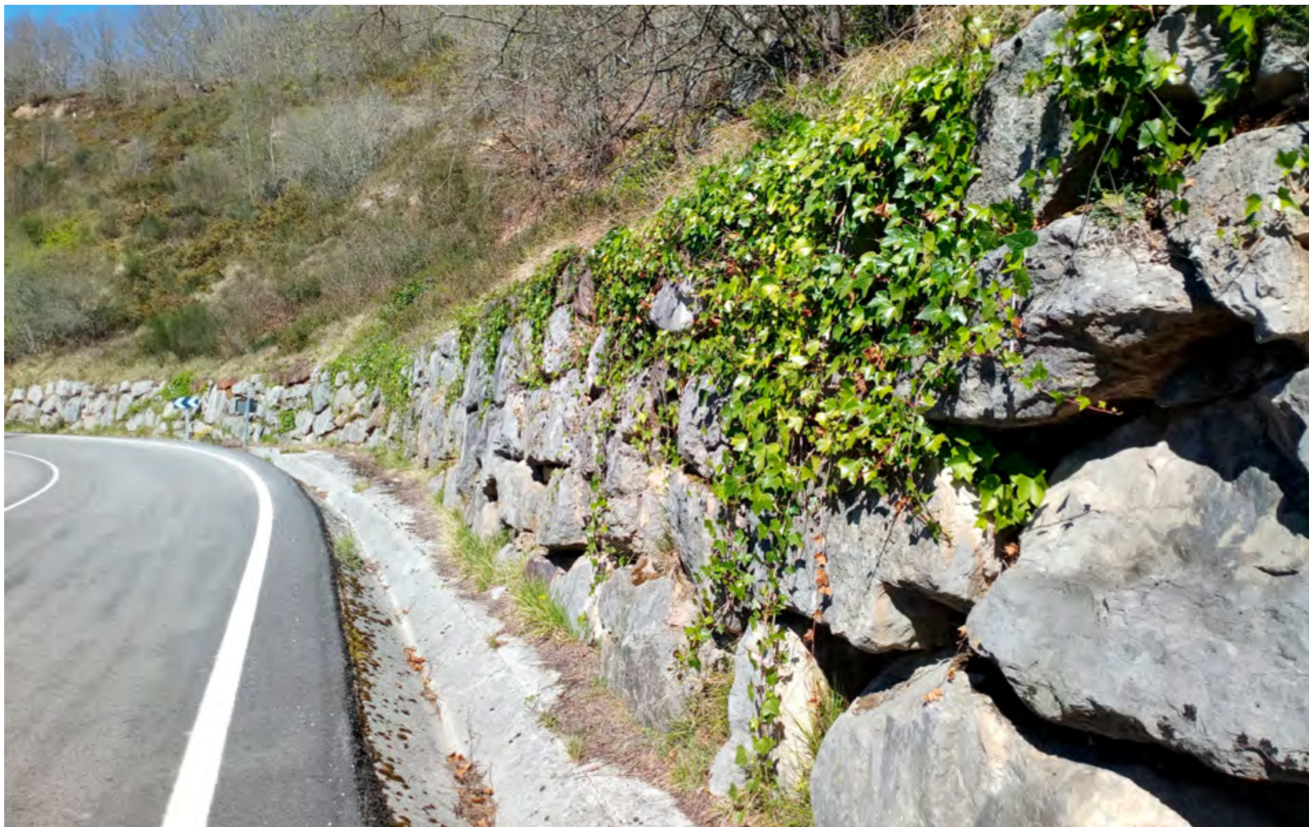
Adequar as datas e frequências de limpeza de manutenção de estradas é a única maneira de manter a Cortaderia controlada nessas áreas
