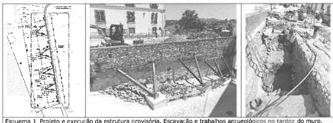
Esquema 1. Projeto e execução da estrutura provisória. Escavação e trabalhos arqueológicos no tardo do muro.
