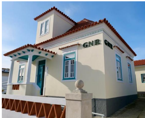
Foto 59 - Edifício da GNR
