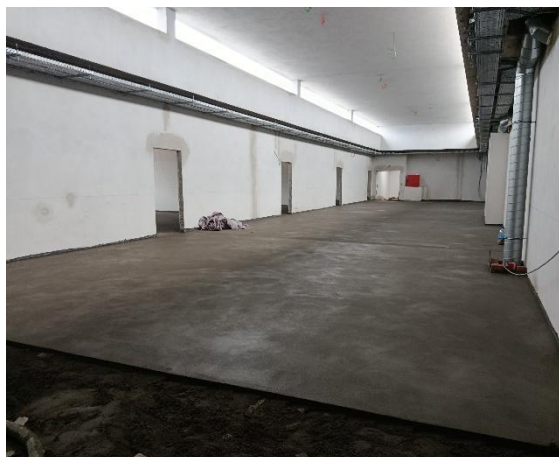
Foto 28 - Bloco C – Piso 1
