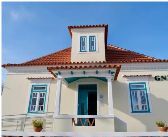
Foto 58 – Edifício da GNR
