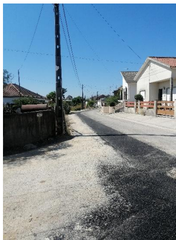
Foto 82 – Fecho de valas
