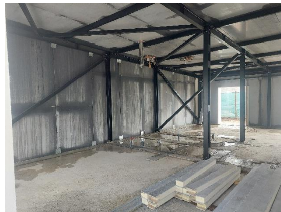
Foto 12 - Vista geral interior
