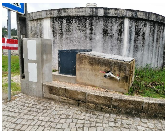
Foto 7 - Furo SL19 - Caldelas
