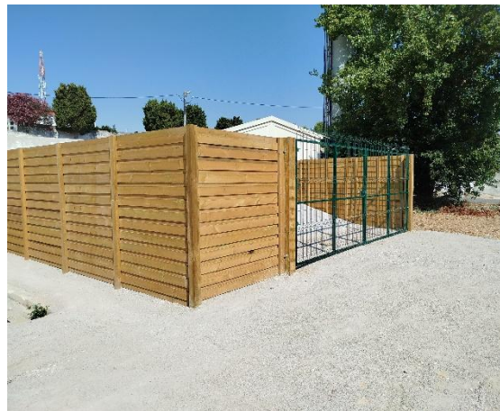
Foto 41 – Espaço para contentores
