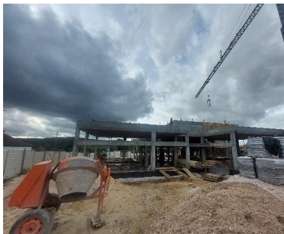
Foto 80 – Estrutura do edifício
