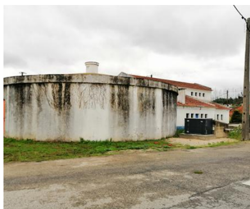
Foto 8 - Furo SL19 - Caldelas
