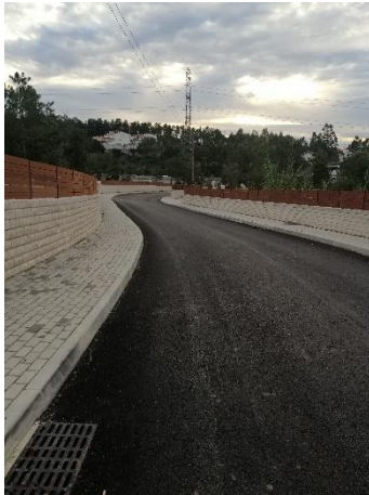
Foto 83 – Rua do Vale
