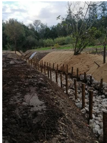
Foto 86 - Desassoreamento de linha de água
