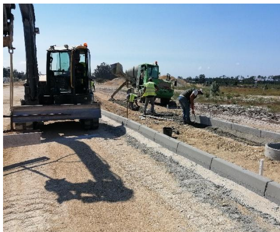
Foto 63 – Colocação de lancis
