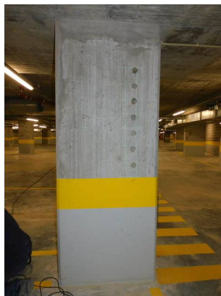
Fig. 7 – Ensaios “in situ” realizados em pilares/paredes. Piso -2. Zona Z(-2).1, com realização de ensaios esclerométricos e ultrassónicos, através do método indireto, na face oeste do pilar.
