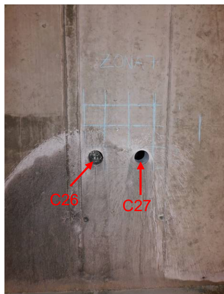
Fig. 17 – Idem. Idem. Idem. Pormenor. De referir a medição da espessura da parede, com 0,20m, através da carote C27 extraída.
