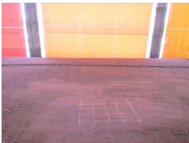
Fig. 20 – Idem. Piso 2. Zona Z(2).1, com deteção da malha de armaduras na face superior da laje, com recurso ao equipamento detetor de armaduras (pacómetro), para extração de três carotes (designadas de C4, C5 e C6) destinadas a ensaios laboratoriais (ensaios de compressão) e realização de janela de inspeção para extração dum varão (amostra designada de A3) destinado a ensaio laboratorial de tração.
