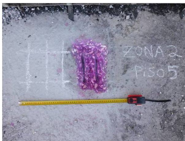
Fig. 40 – Idem. Idem. Zona Z(5).2, com sondagem realizada para medição da profundidade de carbonatação.
