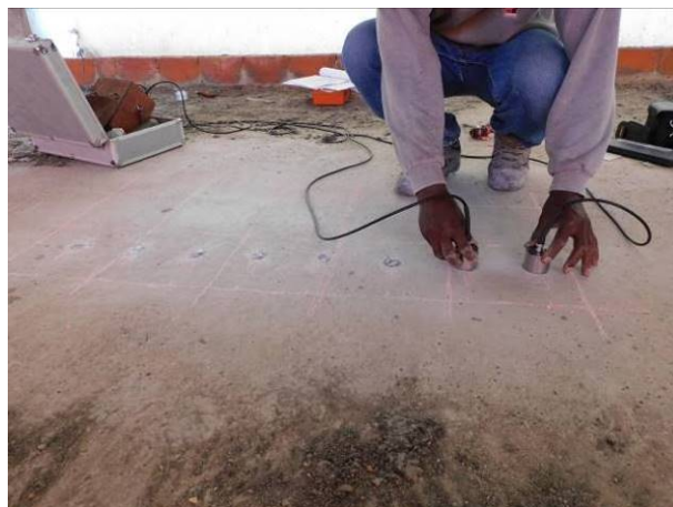
Fig. 5 – Idem. Exemplo de realização do ensaio ultrassónico, pelo método indireto, em elementos de betão.
