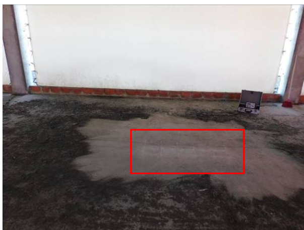
Fig. 44 – Idem. Idem. Zona Z(5).4, com realização de ensaios esclerométricos e ultrassónicos, através do método indireto, na face superior da laje.
