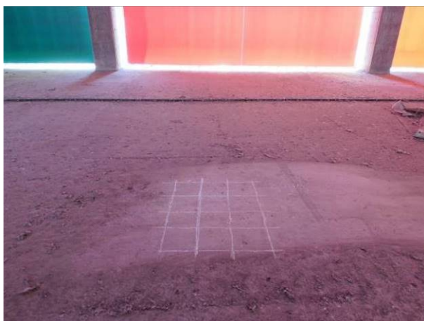
Fig. 24 – Idem. Piso 2. Zona Z(2).2, com deteção da malha de armaduras na face superior da laje, com recurso ao equipamento detetor de armaduras (pacómetro), para extração de três carotes (designadas de C10, C11 e C12) destinadas a ensaios laboratoriais (ensaios de compressão).
