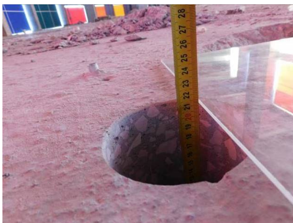
Fig. 22 – Idem. Idem. Idem. Pormenor de medição da espessura da laje, com 0,21m, através do furo de inspeção realizado no orifício de extração da carote C6.
