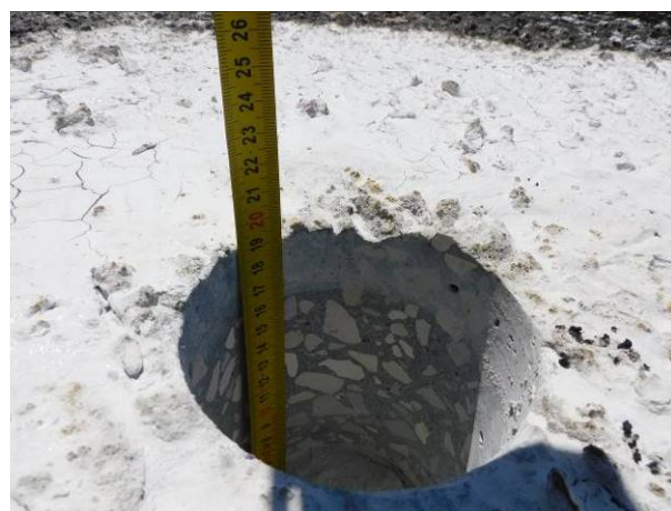
Fig. 39 – Idem. Idem. Idem. Pormenor de medição da espessura da laje, com 0,19m, através do furo de inspeção realizado no orifício de extração da carote C18.
