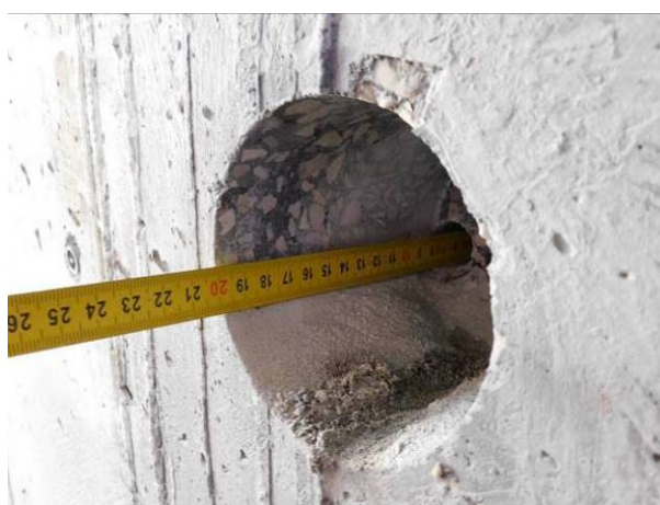
Fig. 15 – Idem. Idem. Idem. Pormenor de medição da espessura da parede, com 0,20m, através do furo de inspeção realizado no orifício de extração da carote C13.
