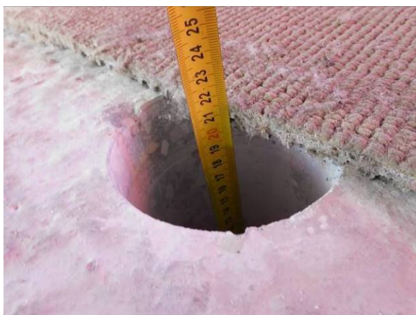
Fig. 26 – Idem. Idem. Idem. Pormenor de medição da espessura da laje, com 0,20m, através do furo de inspeção realizado no orifício de extração da carote C11.
