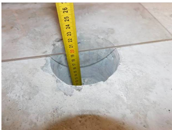
Fig. 34 – Idem. Idem. Idem. Pormenor de medição da espessura da laje, com 0,20m, através do furo de inspeção realizado no orifício de extração da carote C1.
