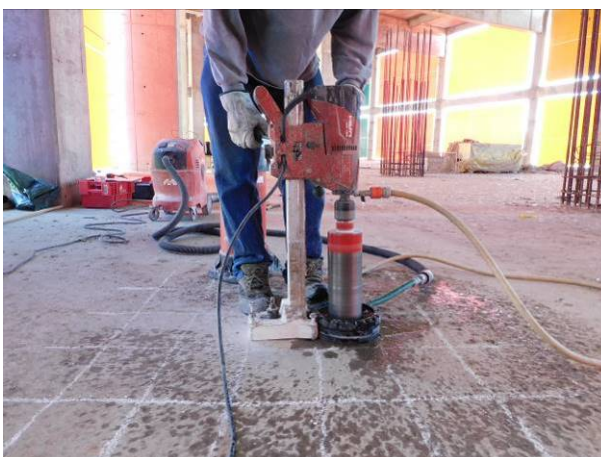
Fig. 6 – Idem. Exemplo da extração de carote destinada a ensaios laboratoriais (ensaio de compressão).
