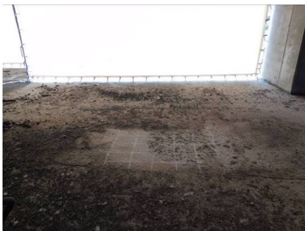
Fig. 28 – Idem. Piso 2. Zona Z(2).3, com deteção da malha de armaduras na face superior da laje, com recurso ao equipamento detetor de armaduras (pacómetro), para extração de três carotes (designadas de C7, C8 e C9) destinadas a ensaios laboratoriais (ensaios de compressão) e realização de janela de inspeção para extração de dois varões (amostras designadas de A1 e A2) destinados a ensaios laboratoriais de tração.
