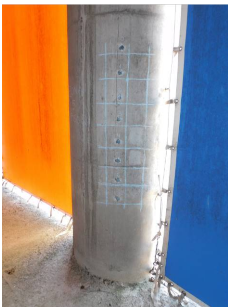
Fig. 12 – Idem. Idem. Idem. Pormenor da zona de ensaios esclerométricos e ultrassónicos realizados no pilar.
