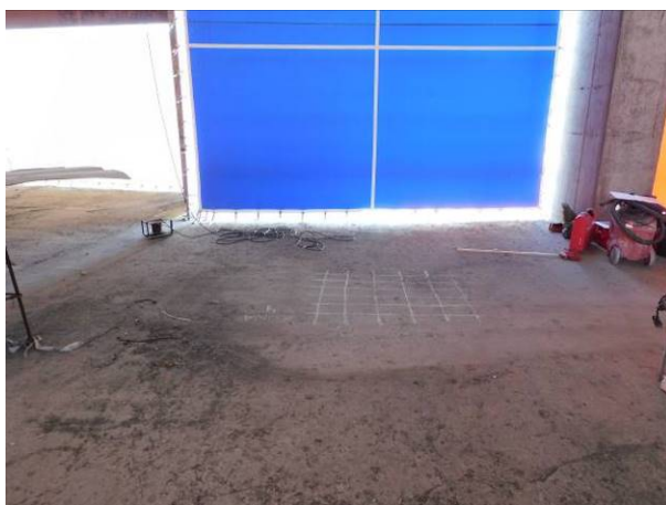
Fig. 32 – Idem. Piso 2. Zona Z(2).4, com deteção da malha de armaduras na face superior da laje, com recurso ao equipamento detetor de armaduras (pacómetro), para extração de três carotes (designadas de C1, C2 e C3) destinadas a ensaios laboratoriais (ensaios de compressão).
