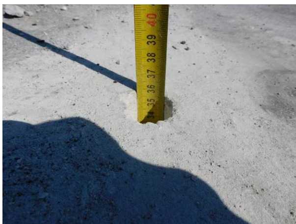
Fig. 48 – Idem. Idem. Pormenor de medição da espessura da laje, com 0,355m, através do furo de inspeção realizado.
