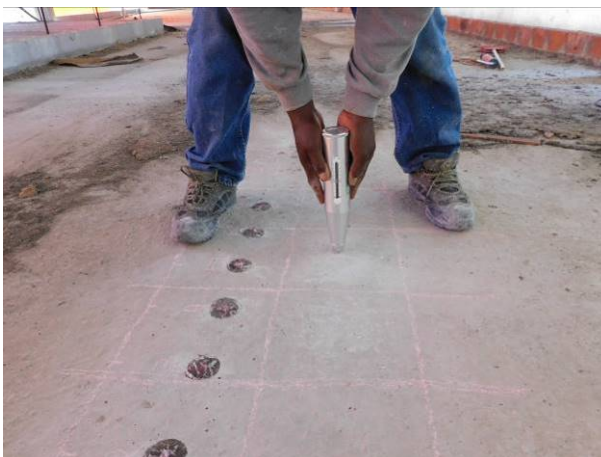
Fig. 4 – Ensaios “in situ”. Exemplo da avaliação da resistência superficial do betão, através do ensaio esclerométrico.
