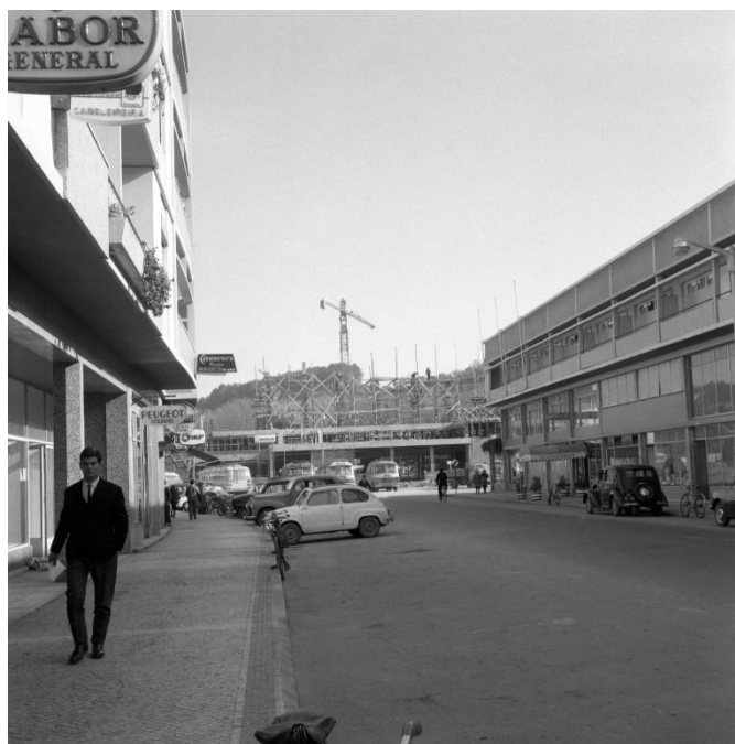
FIGURA 22 – A AVENIDA HERÓIS DE ÂNGOLA E O TEATRO JOSÉ LÚCIO DA SILVA EM CONSTRUÇÃO. FONTE: TJLS.
