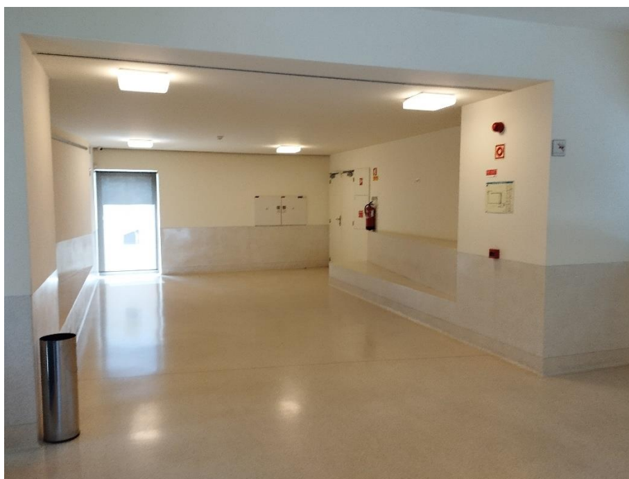
FIGURA 41 – INTERIOR: ACESSO AO 2.º BALCÃO NO PISO 2.
