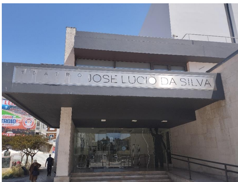
FIGURA 6 – EXTERIOR: ENTRADA PRINCIPAL.
