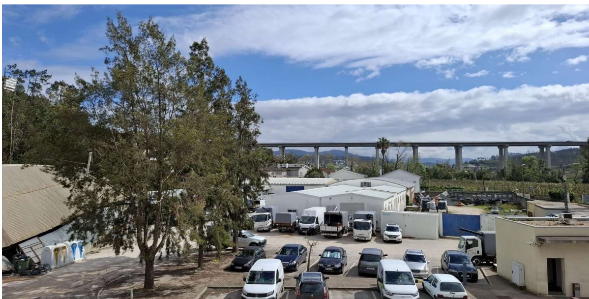
Aspetto dos Novos Telhados
