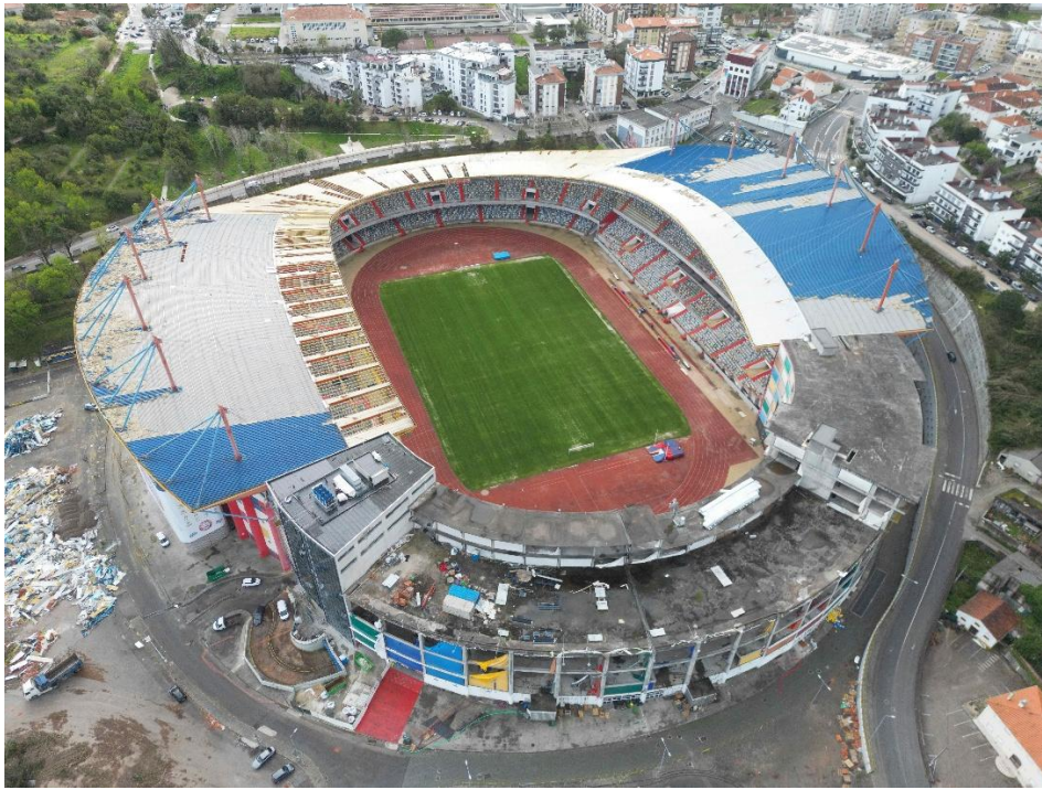
Vista área do Estádio
