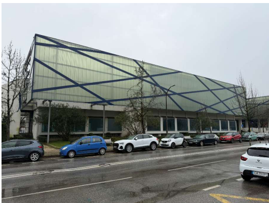
Figura 6A: Vista do alçado norte do topo nascente
