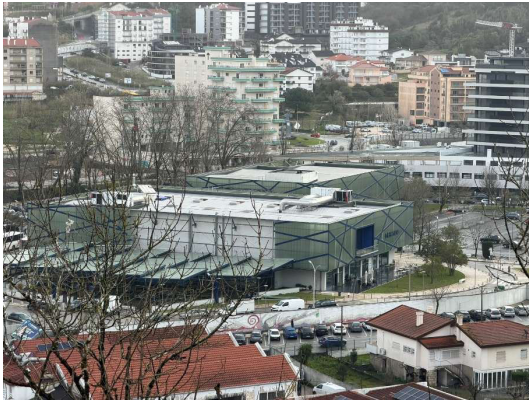
Figura 4A: Vista do imóvel do lado Sudoeste
